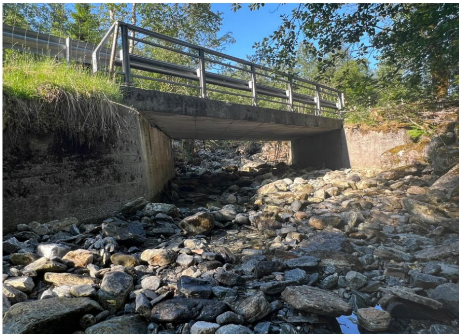
Figur 6: Bildet er tatt nedstrøms dagens bru over sideelva fra Amlistølen. Kilde: Sweco, 2023
