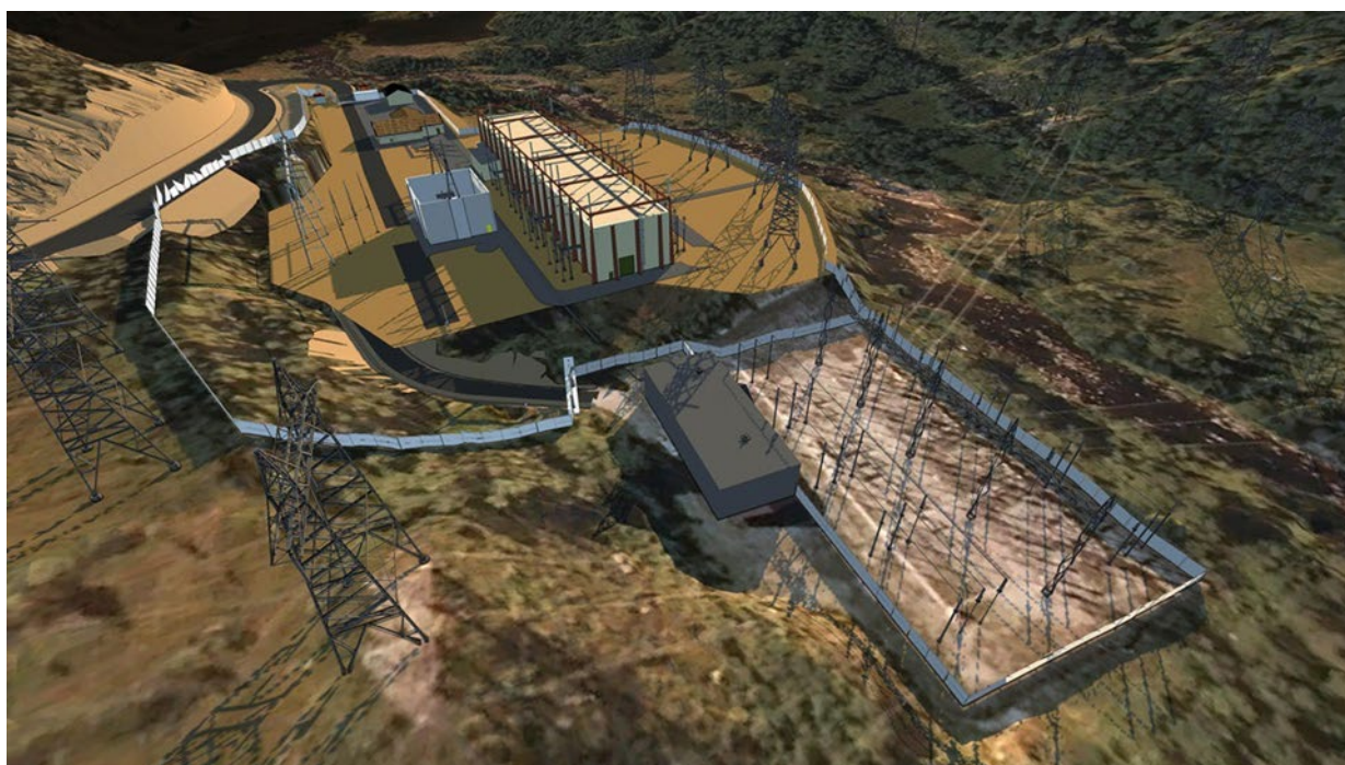
Figur 5: Omsøkte Krossdalen transformatorstasjon sett i sørlig retning
