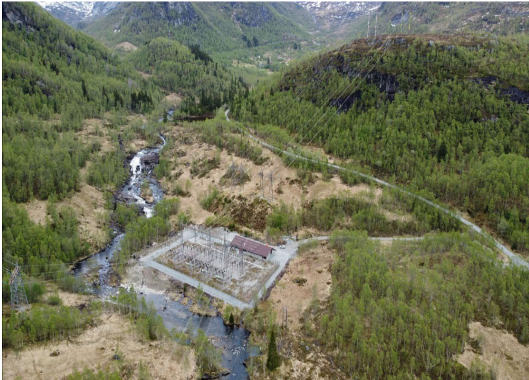
Figur 3: Oversiktsbilde av Modalen koblingsstasjon
