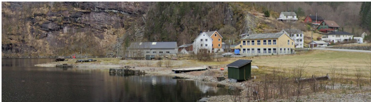
Figur 9: Eidslandet i Vaksdal kommune. Fylkesvei 569 hvor transformatortransporten skal gå vises i bakgrunnen i bildet
