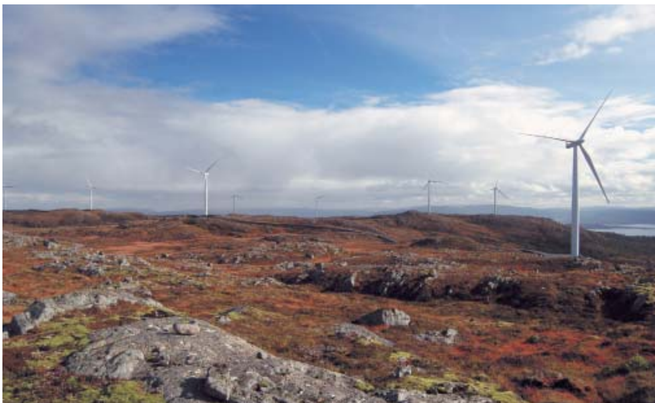
Bilde fra Hitra vindmøllepark (hentet fra Statkraft sine internett sider), viser vindmøller med installert effekt på 2,3 MW.
