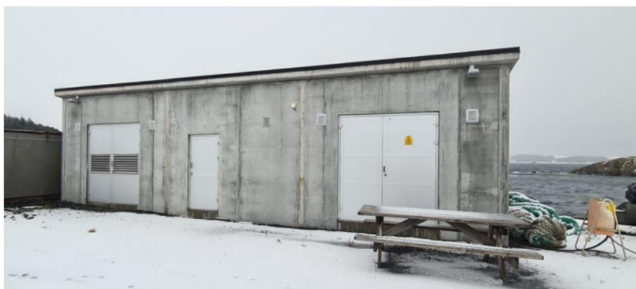
Figur 3. Eksisterende nettstasjon på Kjobogen industriområde for termivering av sjøkabel. Kilde: Lingalaks sin konsesjonssøknad.
