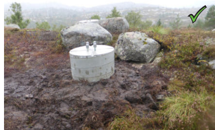
Figur 20: God overgang mellom stabbe og terreng.
