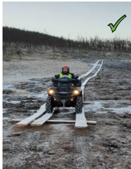
Figur 10: Eksempel på etablert terrengforsterkning over bløte partier.
