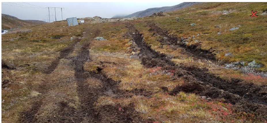
Figur 8: Når det etableres et nytt kjørespor, skal dette benyttes. Entreprenør skal terrengforsterke fremfor å etablere parallelle spor.
