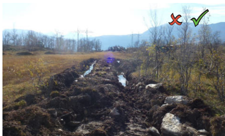
Figur 5: Behovet for terrengforsterkning må sees i forhold til forventet antall transporter forbi. Ved bare en passasje, kan maskinen reparere skadene ved uttransportering.
