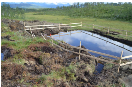
Figur 39: Etabler sedimentsjonsbasseng for håndtering av vann fra byggegrøp for mastepunkt. Bassenget fylles igjen etter bruk..
