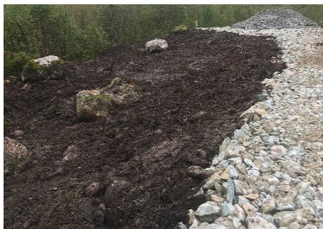
Figur 35: Istandsatt sideterreng i tråd med veilederen fra landbruksdirektoratet, ”Skogsveibygging med miljøhensyn”.
