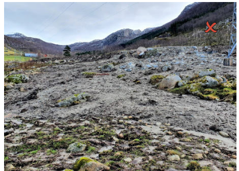
Figur 15: Baseplassen er etablert uten tilstrekkelig kontroll med avrenning. Bløte masser har glidd ut og mengder med finstoff har blitt fraktet over terrenget og ned til et vassdrag. Det har ikke vært etablert tilstrekkelig med avskjærende grøfter for å håndtere intensive nedbørsperioder.
