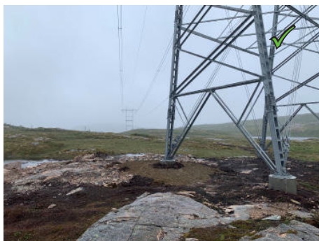
Figur 22: Her er sprengsteinsblokk fjernet fra overflaten.
