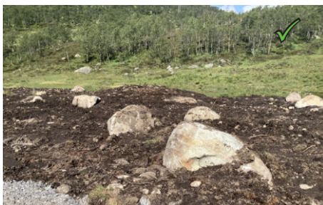
Figur 30: Natirstein som en del av tilbakefylling. Steinen er nedsenket i massene, slik at det fylles rundt basis.
