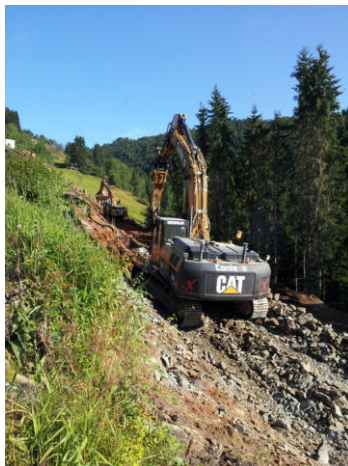
Figur 34: Opprusting av landbruksveg med stedege masser.
