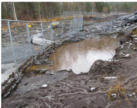
Figur 41: Enkelt sedimentasjonsbasseng for oppsamling av sand og gruspartikler. Viktig at de blir tomte regelmessigt, for å opprettholde funksjonen.
