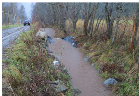
Figur 39: Eksempel der naturlig bekk er utnyttet ved å lage mindre demninger for å samle opp partikler fra vegbygging. Bassengene må tømmes regelmessig, og fjernes når avrenningen opphører.
