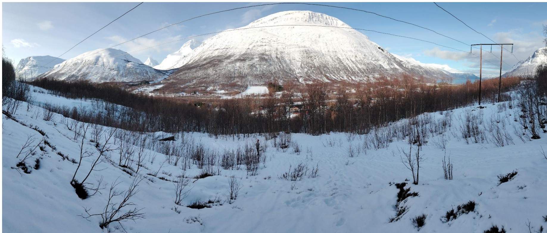
Figur 4-3 Lengst nord i Balsfjordeidet, ved Oterbakken, på nordsiden av Mortensdalen. Det blir en rekke tiltak i terrenget langsetter ledningen her (tiltaksnr. 12-21). Man ser at terrenget domineres av små rygger på tvers av kraftledningen og mange av disse må «slipes» noe ned. Mange av de små ryggene benyttes nok av dyrene når de beiter seg igjennom området. At tiltakene i terrenget er konsentrert helt i det nordvestre hjørnet av beitehagen (Fig. 4-8) og nesten helt inntil eksisterende infrastruktur i dalen reduserer verdien sammenlignet med om det kom mer sentralt (for eksempel hvis det var 420 kV-ledningen som skulle oppgraderes og dette skjedde ved Mortensdalen).
