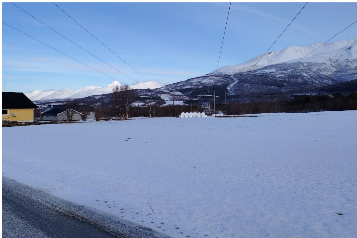
Figur 4-9 Myrdragene opp mot Balsfjord transformatorstasjon (ligger på og mellom jorder). Disse områdene er svært bløte og viktig at man ikke lager varige terrengspor.
