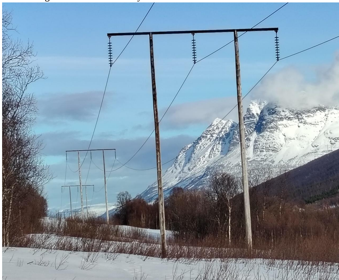
Figur 4-5. På vestsiden av Balsfjordeidet. 132 kV-ledningen går her «innenfor» reingjerdet og anleggsmannskap er avhengig av å dra igjennom porter i gjerdet. Her vil det kun utføres tiltak i mast. Som typisk vil være å «løfte» ledningen (ved at isolatorene henger mer vannrett istedenfor loddrett slik som nå), «dra inn» ledning, eventuelt bytte ut til høyere master.
