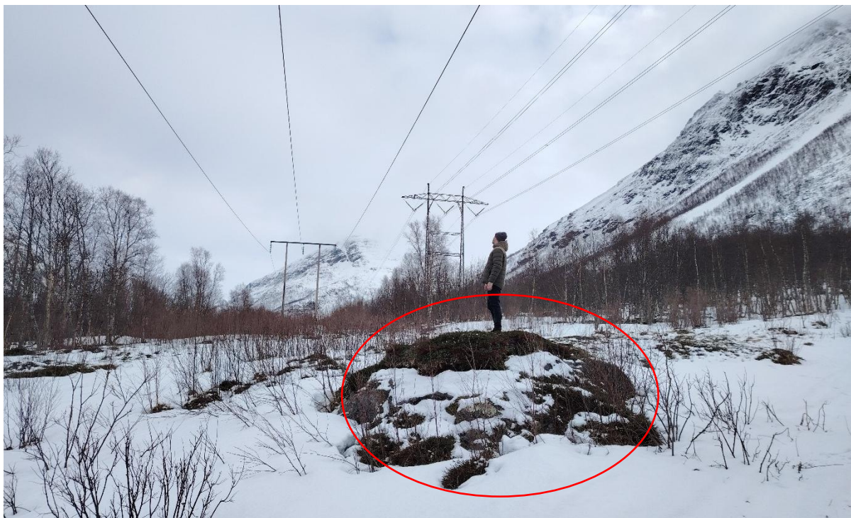
Figur 2-2 Eksempel på tiltak (tiltaksnr. 11 fra Tabell 2-1): Bilde av stein (rød sirkel) som må graves/sprenges bort øverst i Kittdalen. Denne steinen ligger midt mellom to mastepunkter, hvor ledningen henger lavest.
