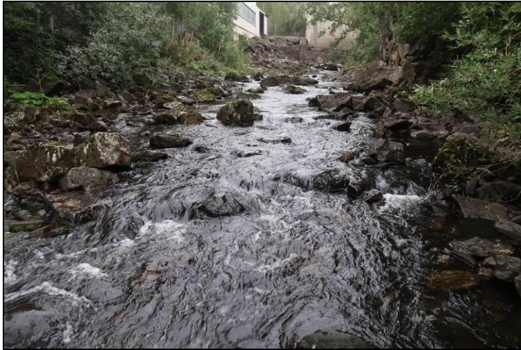
Figur 73. Bilde av Andelva, restløp ved Bøhn kraftstasjon.
