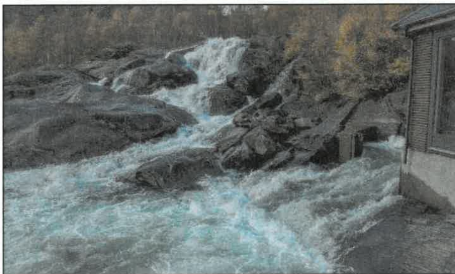
Figur 3. Østerdalselva med inntaket til Kistafossen kraftverk (øverst), med øvre del av kraftverkets rørgate ved kryssing under RV17 (midten) og Kistafossen med Kistafossen kraftverk og utløpet derfra (nederst).
