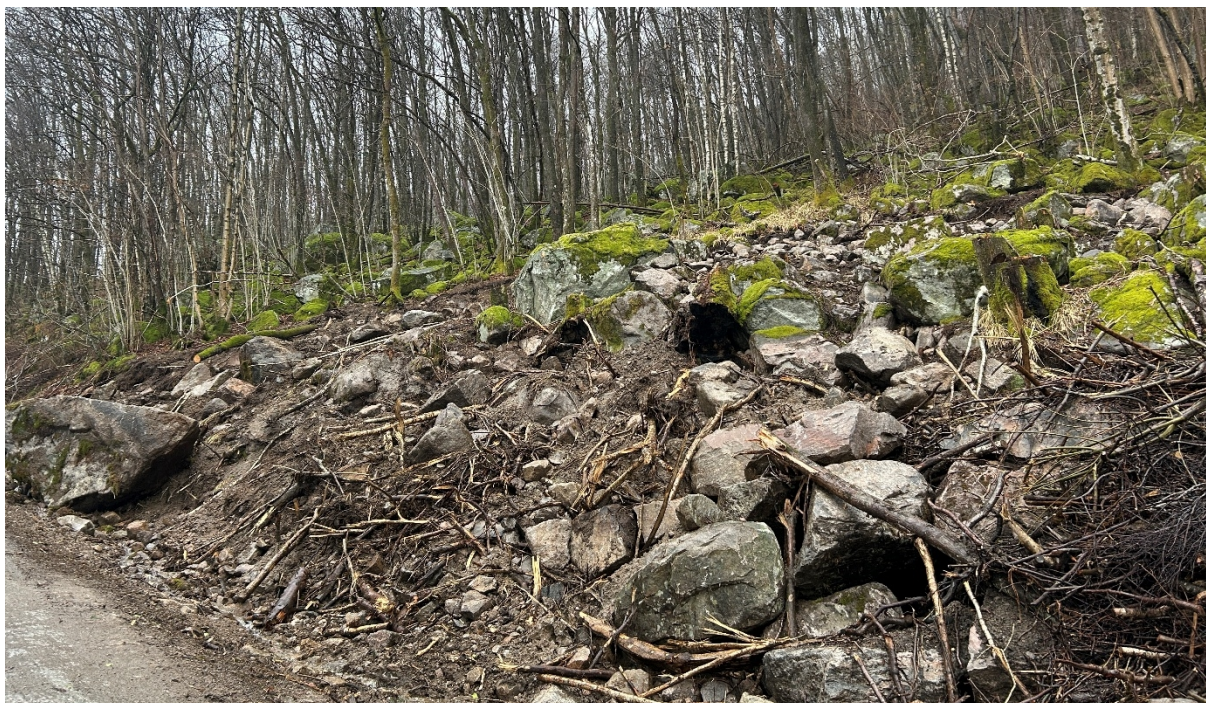
Figur 2: Kraftstasjonstomta bærer preg av bratt og ulendt terreng. Inngrep i terrenget vil kreve ytterligere sikring.
