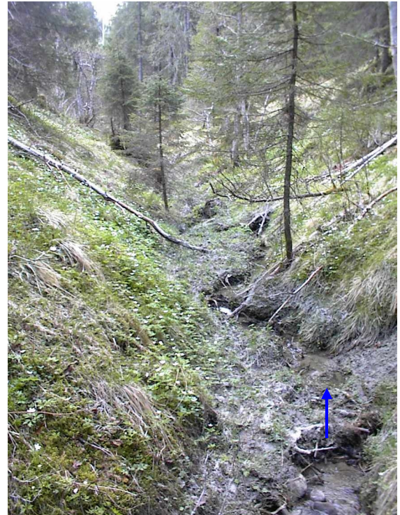
Sidebekk 4 , øvre ende av strekning som er planlagt sikret (bilde 32)
