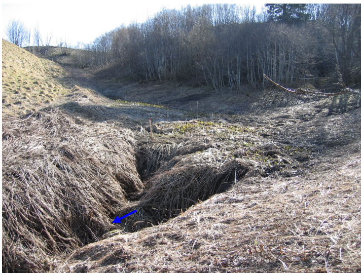
Sidebekk-1 øverste del av strekning som skal sikres (bilde 5)
