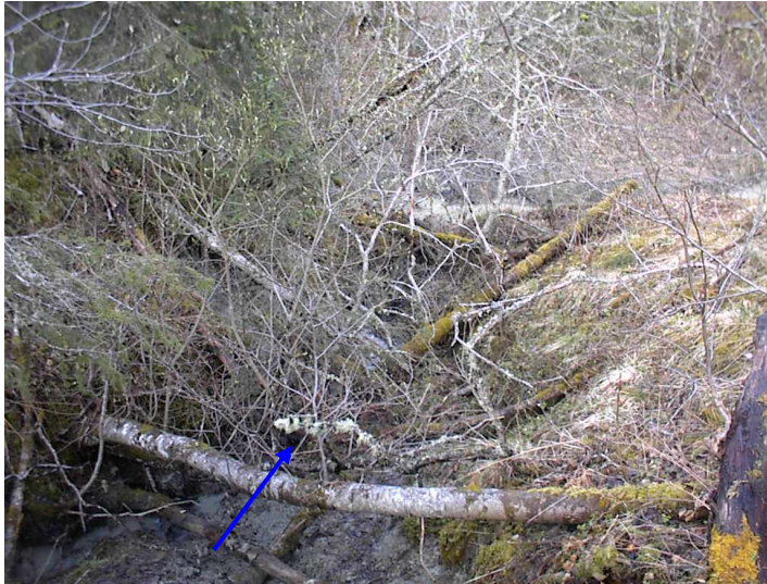
Ravine-17 , ved kulverten under Tillebruvegen (bilde 17)
