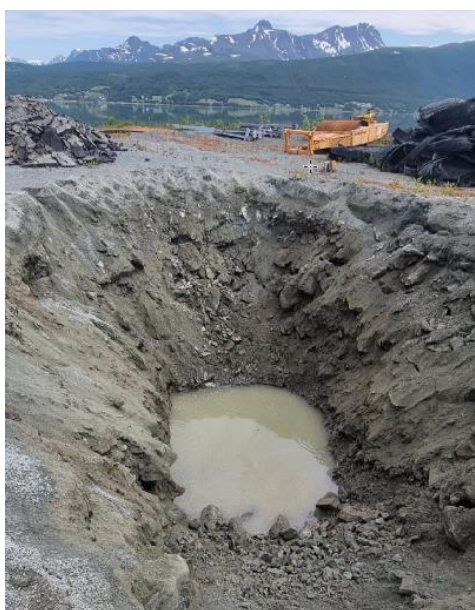
Figur 3-5: Prøvegraving utført i 2022 [B] og viser at fyllmassene er sprengstein. Topp fylling er på ca. kote 2,7 og vannspeilet er på ca. kote minus 1.
