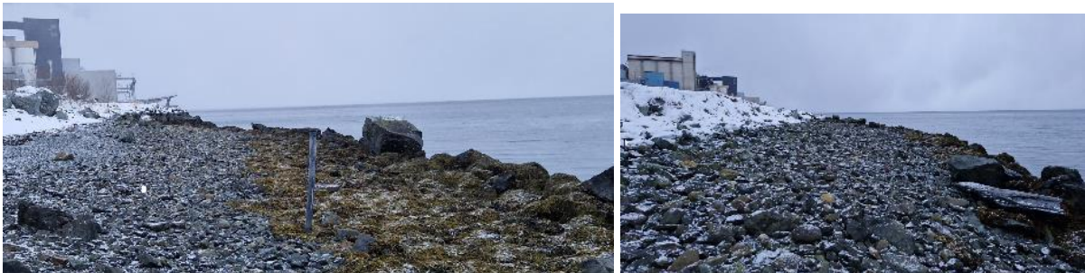
Figur 5-13: Motfyllingen utenfor østlige industriområde. Det er blokker/store steiner ved fyllingsfronten.
