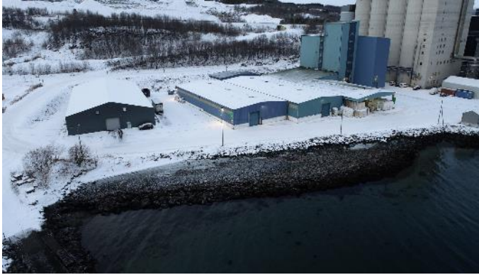
Figur 5-12: Dronefoto av motfyllingen utenfor Felleskjøpet
