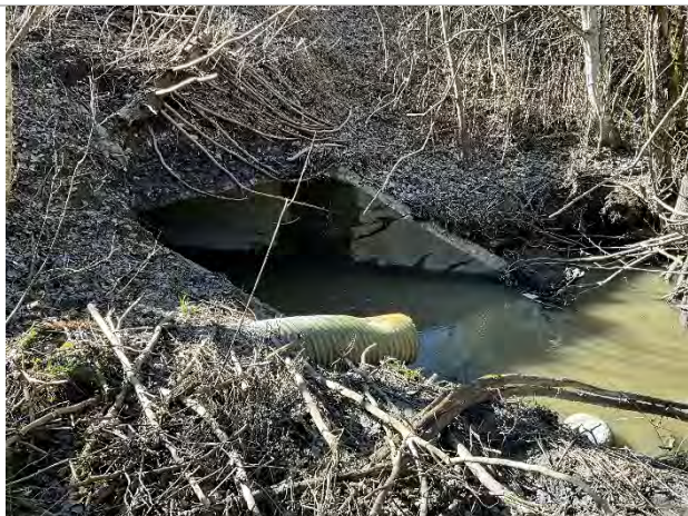
Bilde 20. Kulvert under Egnerveien, utløpet i nord. Flere rør ble observert nord for kulverten (fører overvann til bekken?)
