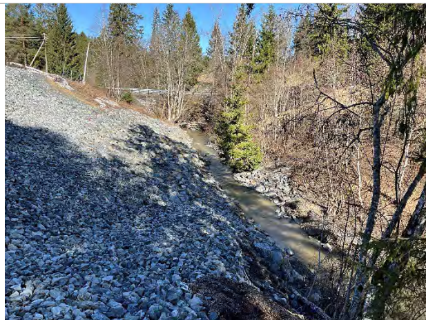
Bilde 21. Steinfylling og plastring i skråningen nedfor driftsbygget. Sett mot nord/vei-kulvert.
