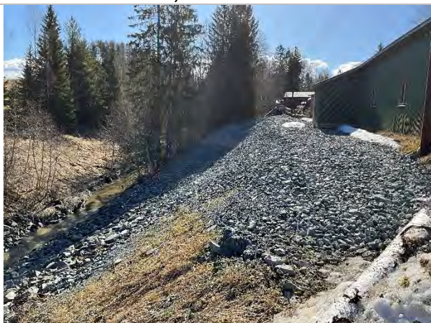
Bilde 22. Steinfylling og plastring i skråningen nedfor driftsbygget. Sett mot sør.
