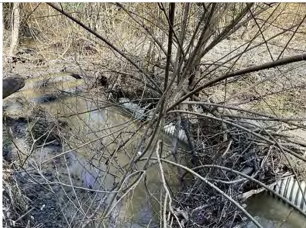
Bilde 30. Det er plassert tømmer i bekken (ligger også mange stokker oppå kanten), kanskje det var tidligere en «bro» her. Det ligger også et stort rør i bekken, delvis tildekket av jord/busker. Bekken har erodert i vest kanten av bekken.
