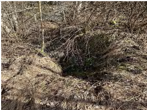
Bilde 32. Liten grop-sannsynligvis dannet av grunnvannserosjon. Ikke vann ved befarings.
