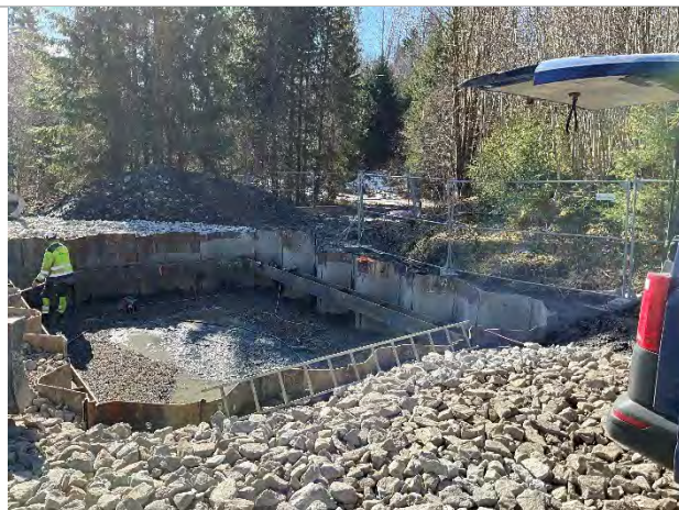
Bilde 25. Ny pumpestasjon under bygging.
