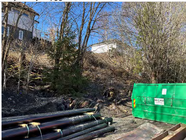
Bilde 24. Skråningen nedenfor Solveien 13 og 14. Ingen tegn på bevegelser. Mye hageavfall ved skråningskanten.
