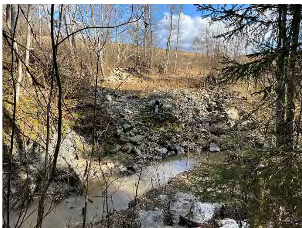
Bilde 38. Avslutning av oppfylt (sikret) ravine. Stor steinplastret skråning; to rør med rennende vann på østsiden av bekken. Merk: eksponert leire (overflateglidning) på venstre side av bilde. Sett mot øst.
