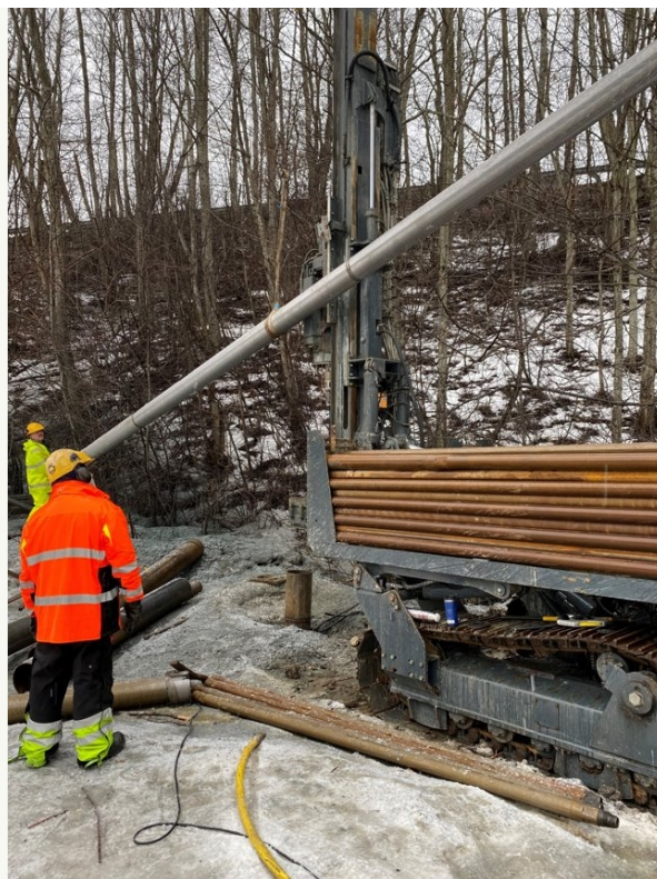
Figur 2-5. Bilder fra etablering av P3. Nedsenkning av brønnfilteret i brønnen.
