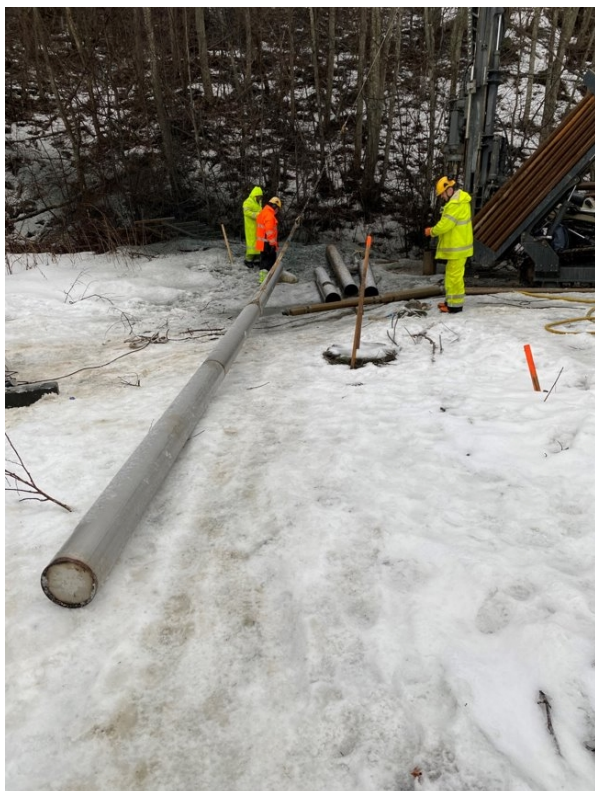
Figur 2-5. Bilder fra etablering av P3. Nedsenkning av brønnfilteret i brønnen.
