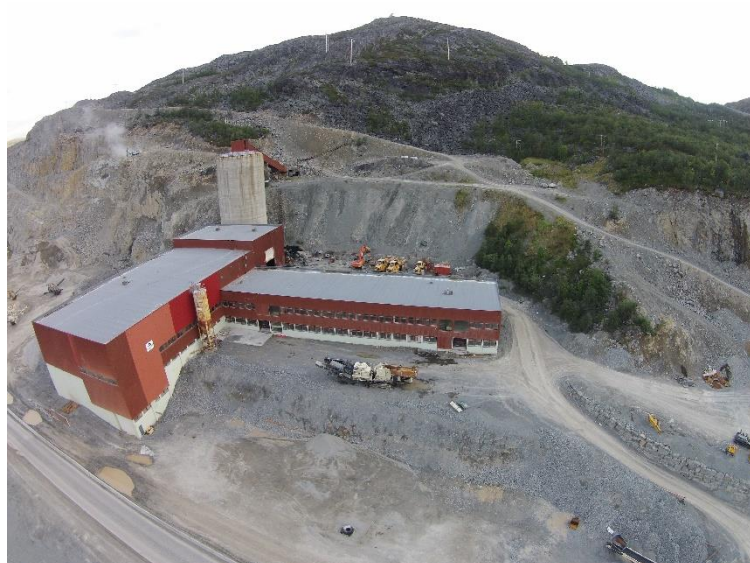
Figur 9 - Øyen industriområde, tunnelinnslag kan ses vedsiden av silo
