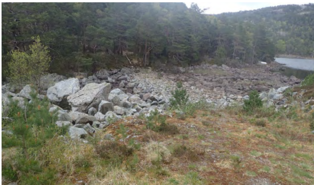
Figur 5. Bildet er tatt den 08.05.2019 ved utløpet til Paddevatnet, mot øst. Bildet viser veien som går over utløpet, som er der ny dam er tenkt plassert. Vannstanden er her under normal vannstand. Hentet fra søknaden, vedlegg 7.
