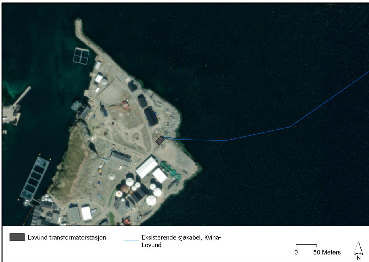
Figur 5-7: Flyfoto av området rundt Lovund transformatorstasjon.
