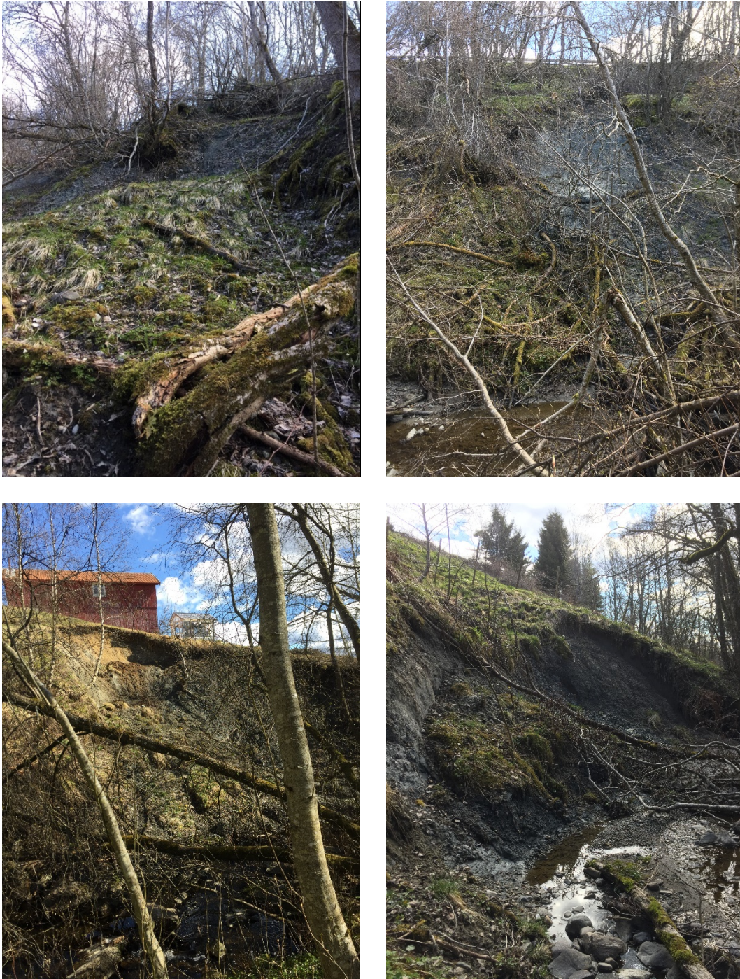
Figur 4: Kraftig erosjon og flere utglidninger i Korsgatabekken
