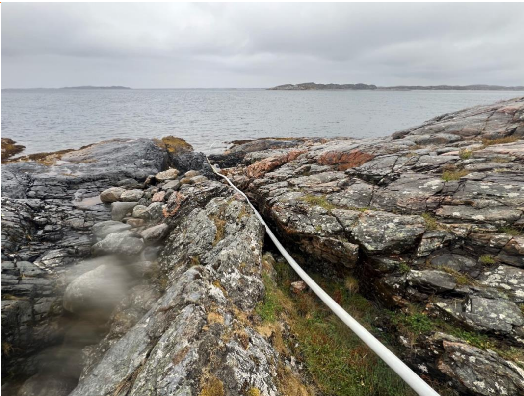
Figur 10. Røret går videre ut i havet liggende i forsenkning oppå fjell/terreng. Bilde: Gunnar Kristiansen
