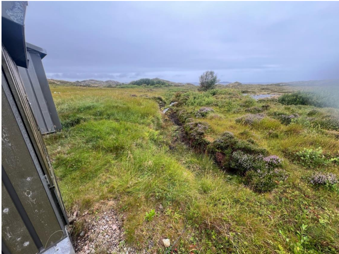
Figur 27. Bilde av området ved trafostasjonen som kunne hatt behov for litt bedre arrondering og revegetering.
