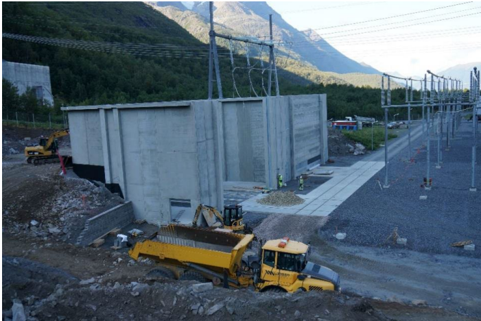
Figur 3: Eksempel på transformatorsjakter i betong
