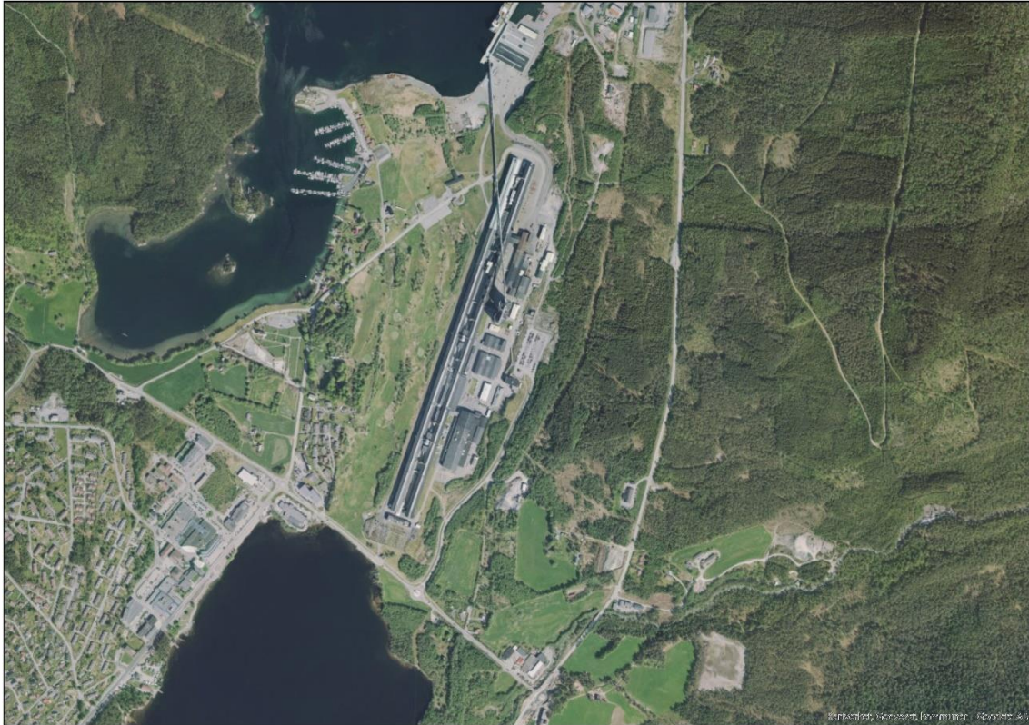
Figur 4. Ortofoto som viser Husnes trafostasjon og Hydro. Kilde: Kommunene/Geovekst
