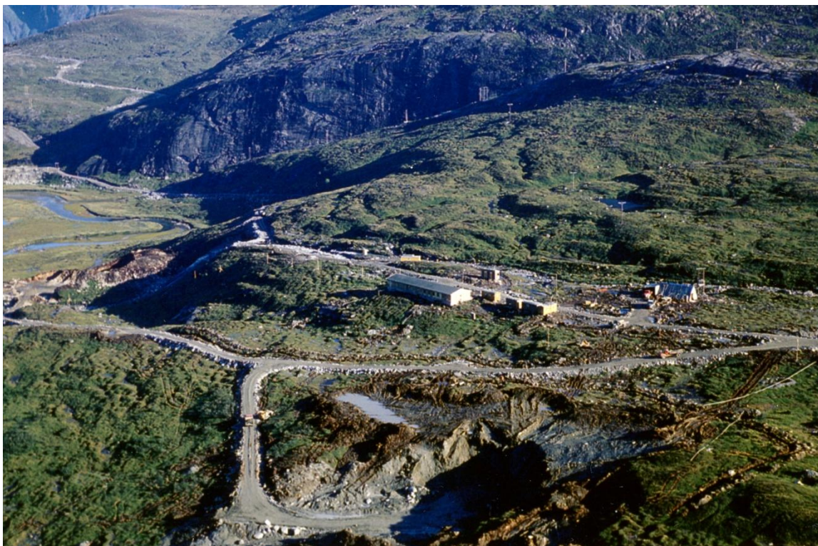
Figur 2-2. Bilete frå tidleg 60-tal av anleggsområdet like nedstrøms Tyssevatnet. Bilete syner brakkerigg, massetak og veggnettverk på fjellet som er der enno i dag.
