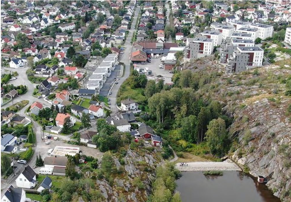
Figur 11: Bingedammen sett fra nord.
