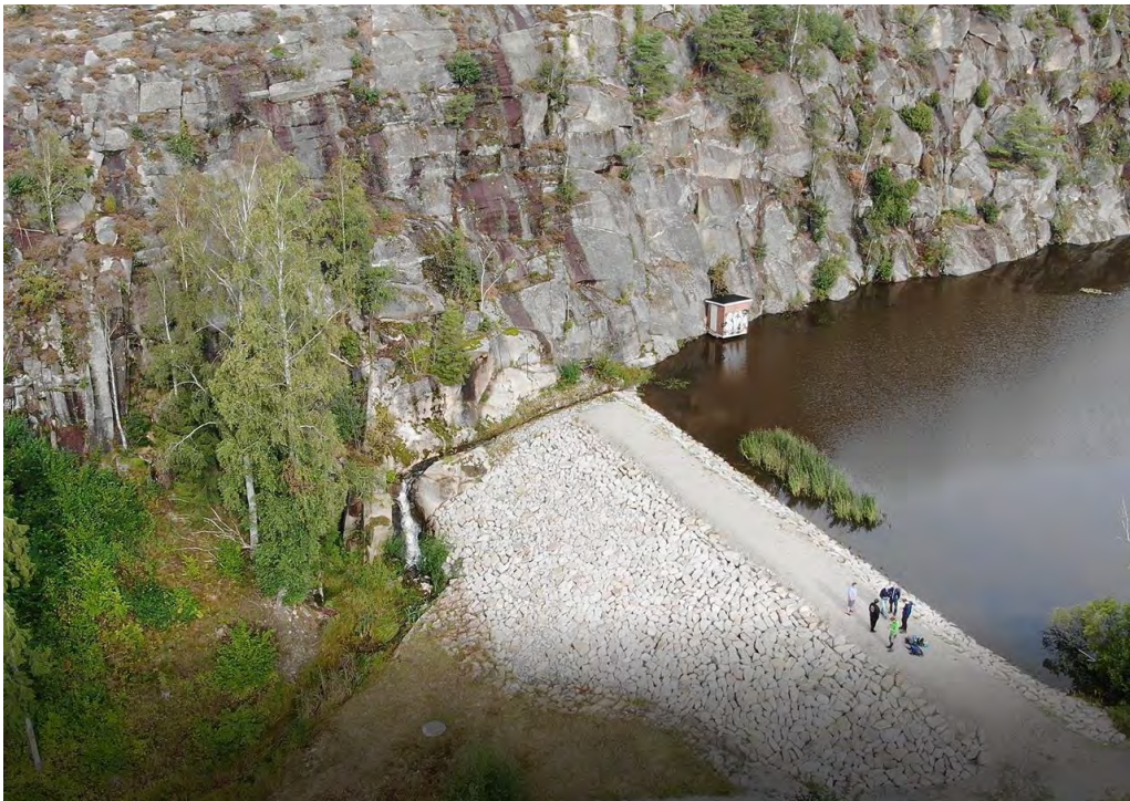
Figur 12: Dammen fikk ny plastring på oppstrøms og nedstrøms side ved rahabilitering i 2013/2014. Flomløpet synes inntil berget mot vest.
