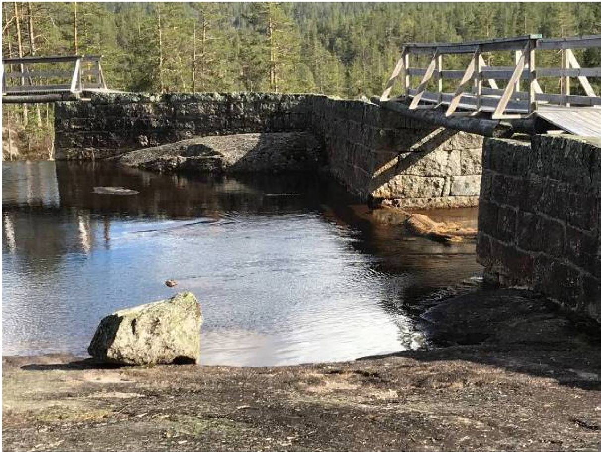
Bildet viser dammen i utløpet av Bjønntjønn
