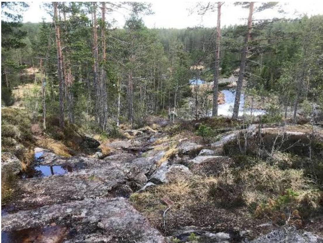
Bilde 35: Trase for pumpeledning sett ned mot pumpestasjon. Foto: Rolf Amundsen
