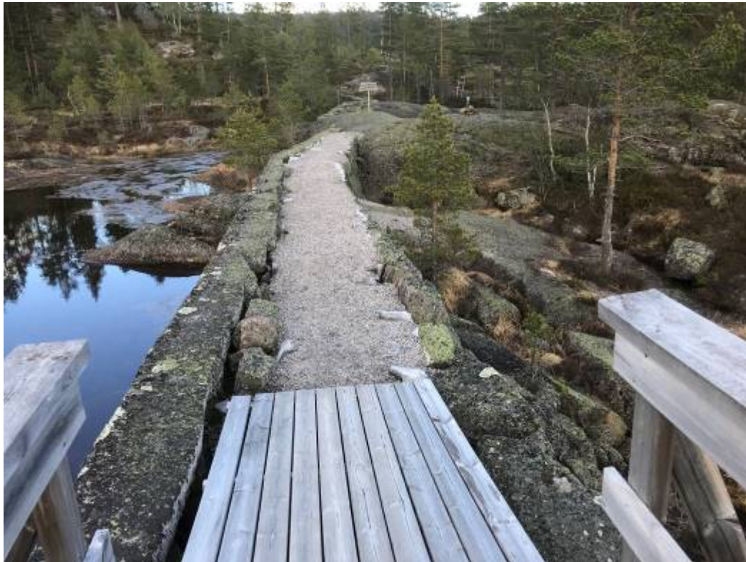
Bilde 31: Bjønntjønn dam sett mot øst. Foto: Rolf Amundsen
