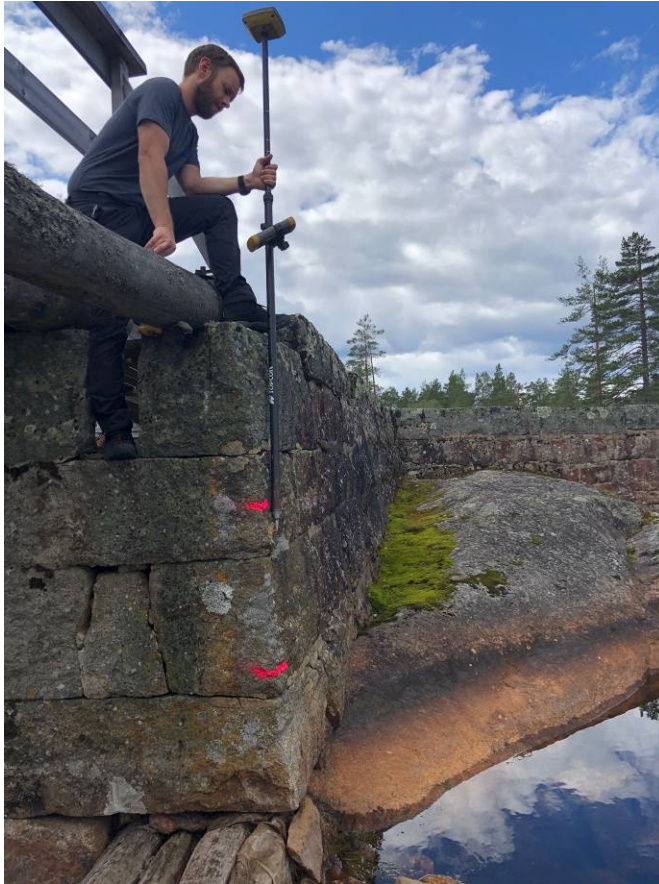
Bilde 45: Bjønntjønn dam – Østre del.
