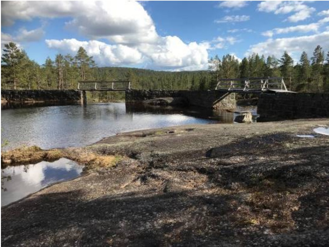
Bilde 29: Bjønntjønn dam, med begge nåleløp. Foto: Rolf Amundsen
