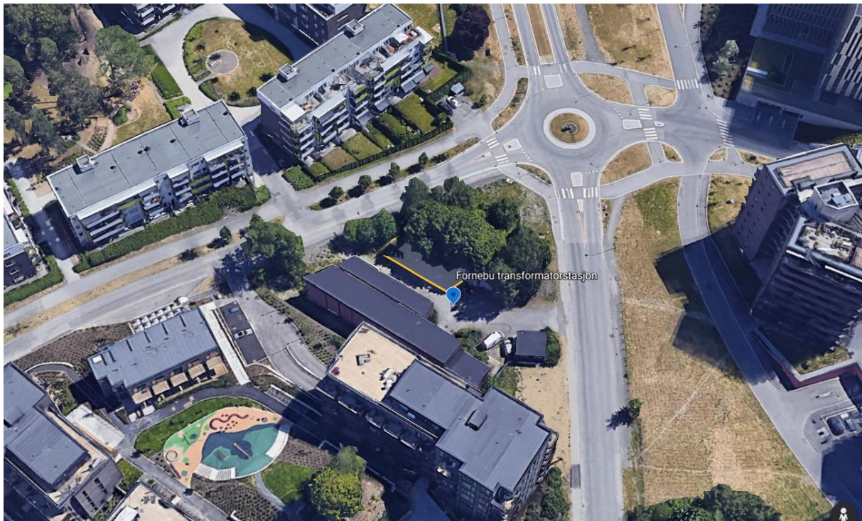
Bilde 1: Fornebu transformatorstasjon (sett fra nord-vest) med omkringliggende boligbebyggelse. Gult polygon viser plassering av de to nye byggene for transformator og spole.
