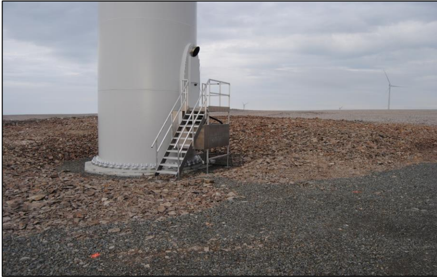
Figur 3. Fundament og tårn etter tilbakefylling av masse (Raggovidda vindkraftverk).
