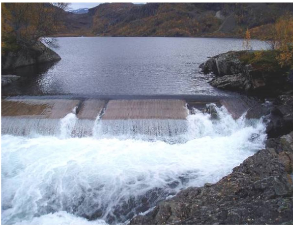
Dam sett østover (før rehabilitering).
