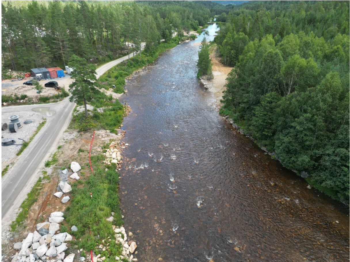
Bilete 3. Bilete av råka strekning i Hovlandsdalselva nedstraums kraftstasjonen ved liten til middels vassføring, 13.08.2023. Vassføring truleg om lag 3\text{m}^3/\text{s} .
