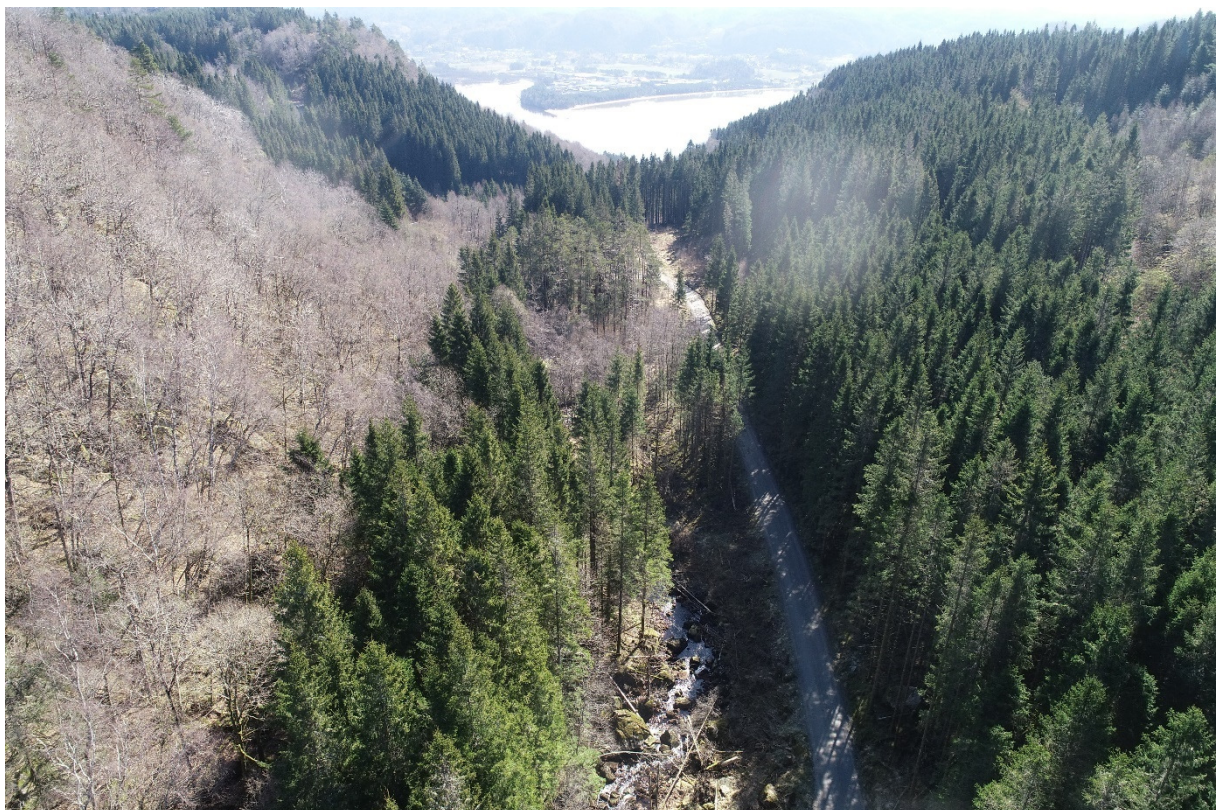
Bilde 4 – Oversiktsbilete teke like nedstraums inntaksdammen, av øvre til midtre delar av vassveg. Området er prega av granfelt og blandingsskog. Vassvegen føl venstre side av Lastadbekken til kraftstasjonen.
