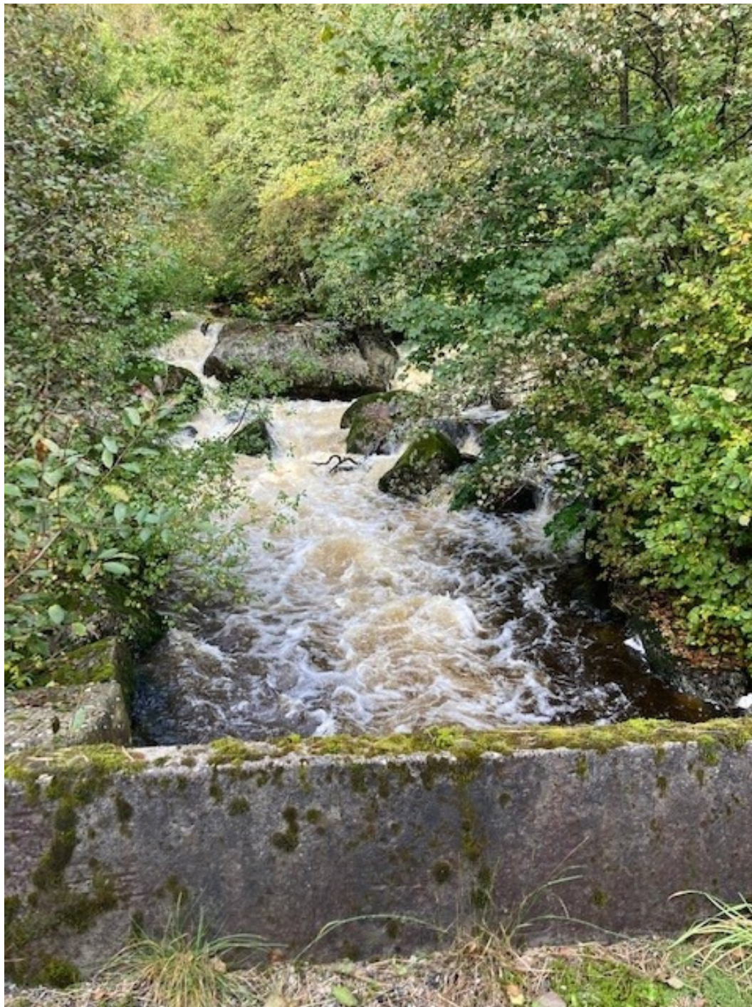
Bilde 8 – Lastadbekken. Bilete teke i oppstraums retning frå brua ved inntaksdam. Vassføring om lag 1400 l/s (01.10.22).
