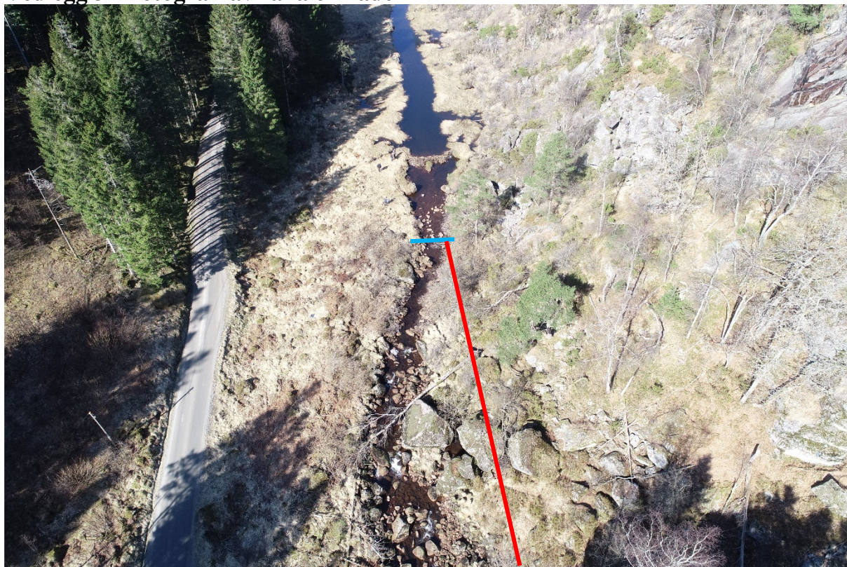
Bilde 1 – Oversiktsbilde av inntaksområde før utbygging. Blå linje viser plassering av damkonstruksjon, raud linje viser kvar rørtraséen er tenkt.
