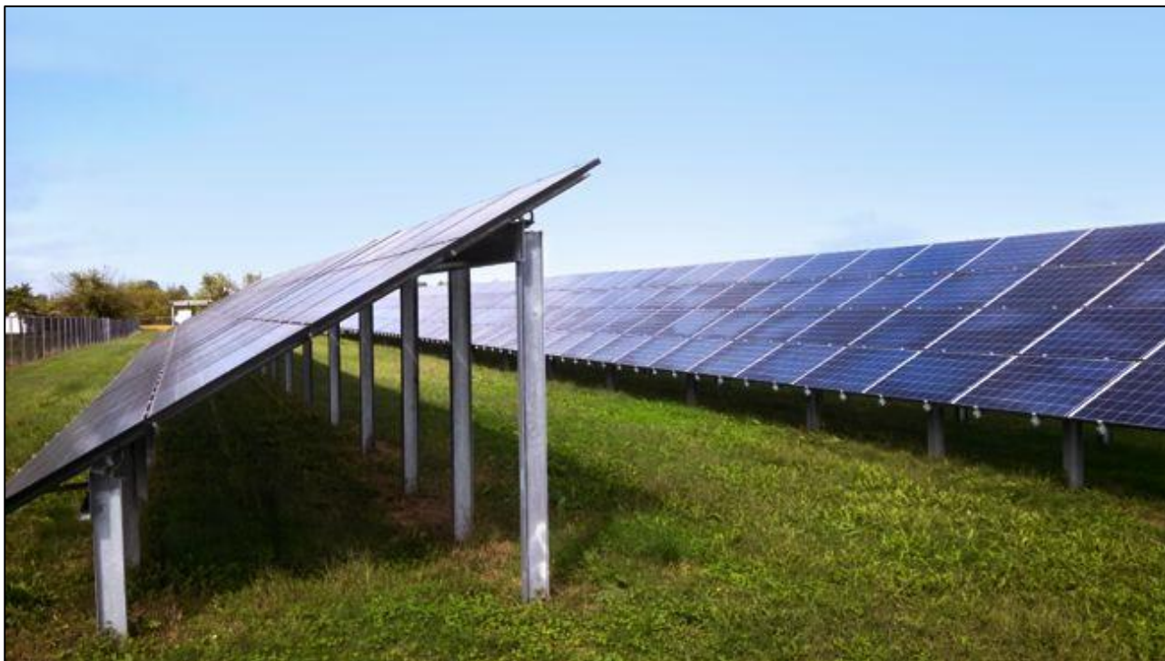
Figur 3-1: Fast-vinkel installasjonsløsning (foto: Willowbrook Solar).
