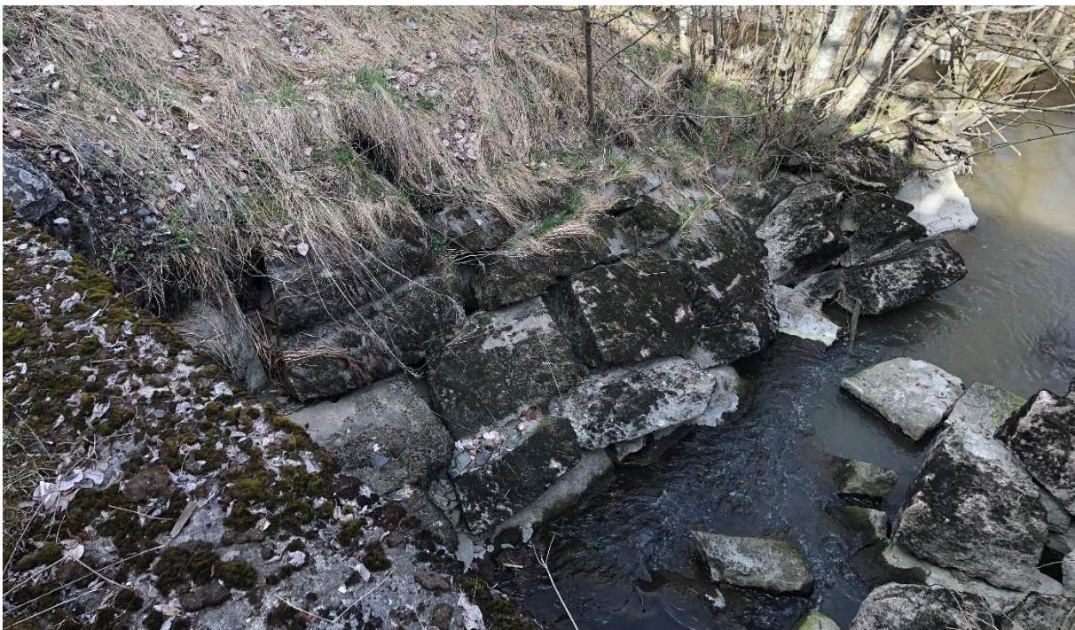
Figur 8.39 Eksisterende brukonstruksjon, bilde tatt fra østlig side av banen. Østfoldbanen østre linje km 5.024. Bilde: IMG_3126.JPG (Jakob Bitsch Jensen, 22.04.2021).
