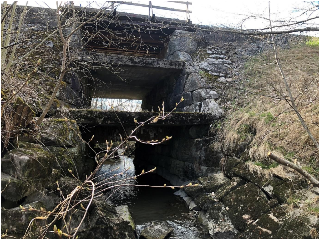
Figur 8.37 Eksisterende brukonstruksjon, bilde tatt fra østlig side av banen. Østfoldbanen østre linje km 5.024. Bilde: IMG_3117.JPG (Jakob Bitsch Jensen, 22.04.2021)
