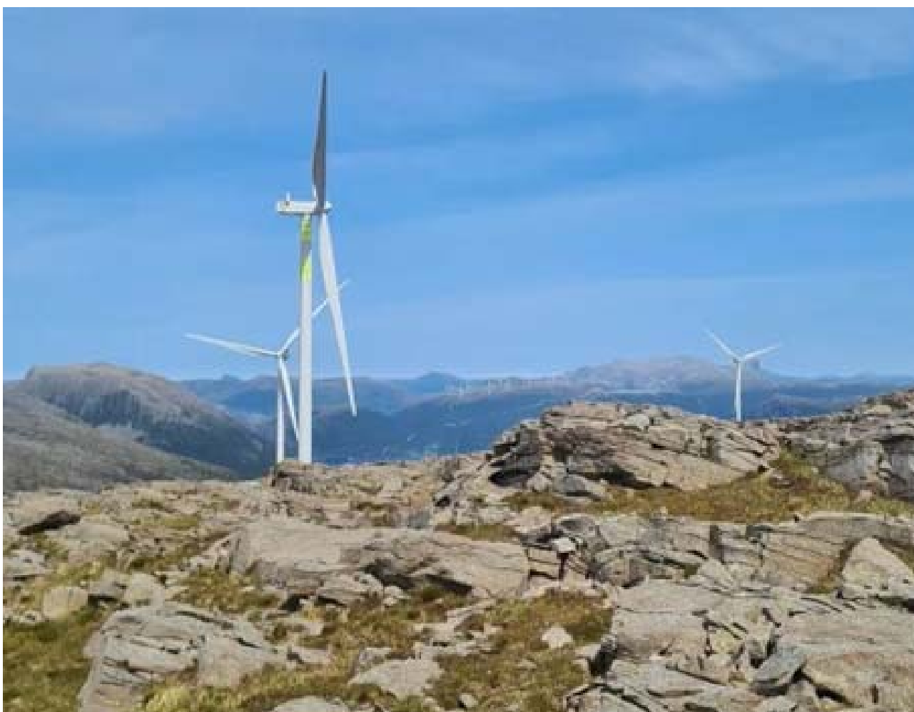
Figur 3-7 viser bilder av fargebånd utført med gul reflekterende farge på en vindturbiner i Guleslettene vindkraftverk. Foto: NRK
