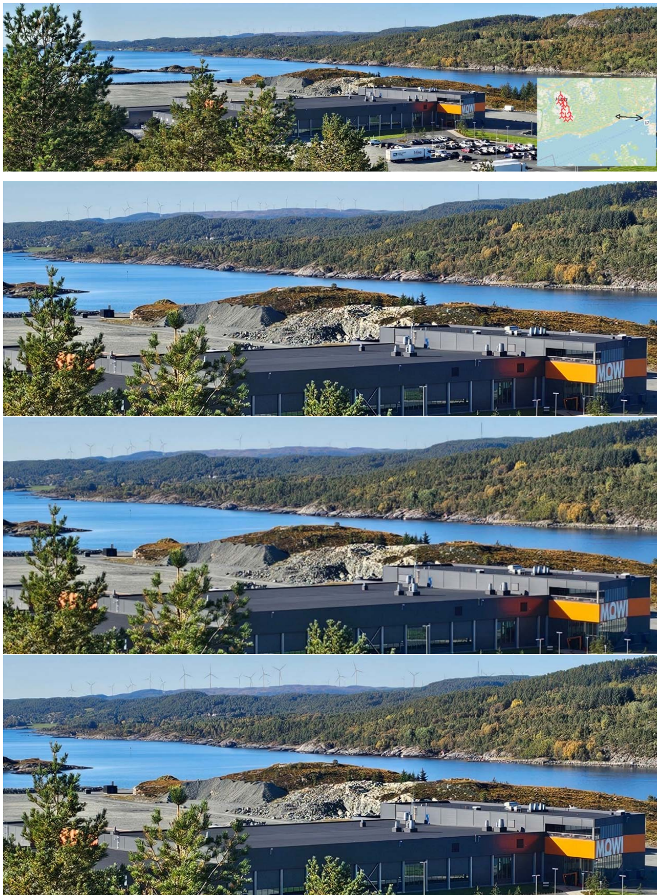
Figur 5-53: Hitra Vindkraftverk sett fra Jøsnøy (standpunkt 17 fra Figur 5-48, avstand 13 km), med anlegget til Mowi i forgrunnen. Eksisterende situasjon øverst, 0-alternativet, der Hitra 1 er sanert bort, i midten, og Nye Hitra 1 vindkraftverk nederst.
