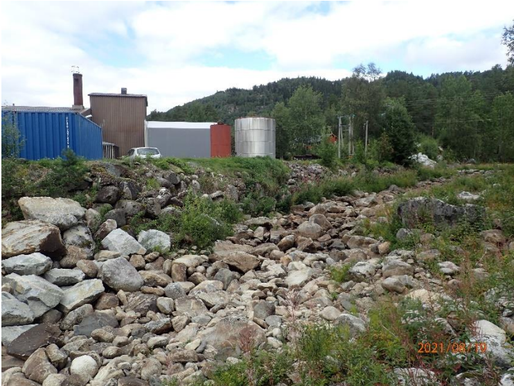
Figur 1-42 Meieriet sett fra nedstrøms side.
