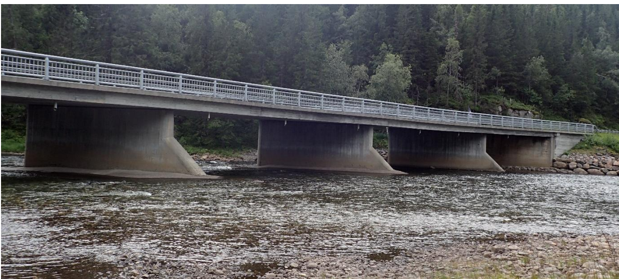
Figur 1-32 Bru Vinje, oppstrøms side.
