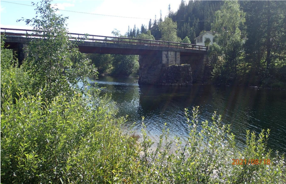
Figur 1-26 Bru til Vinjevegen 2424.
