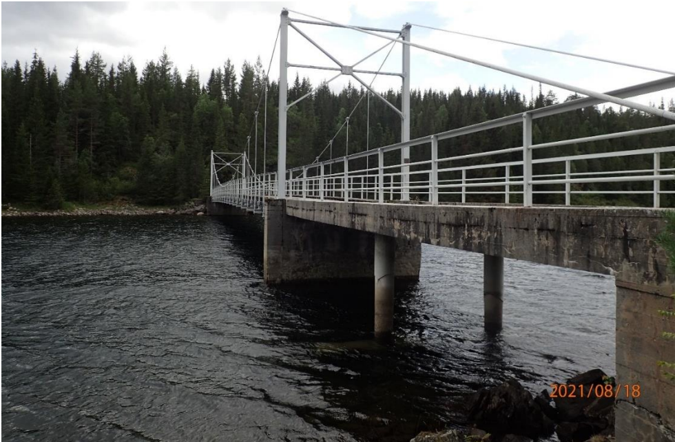
Figur 1-36 Bru over Bukkevalihylen, nedstrøms side.
