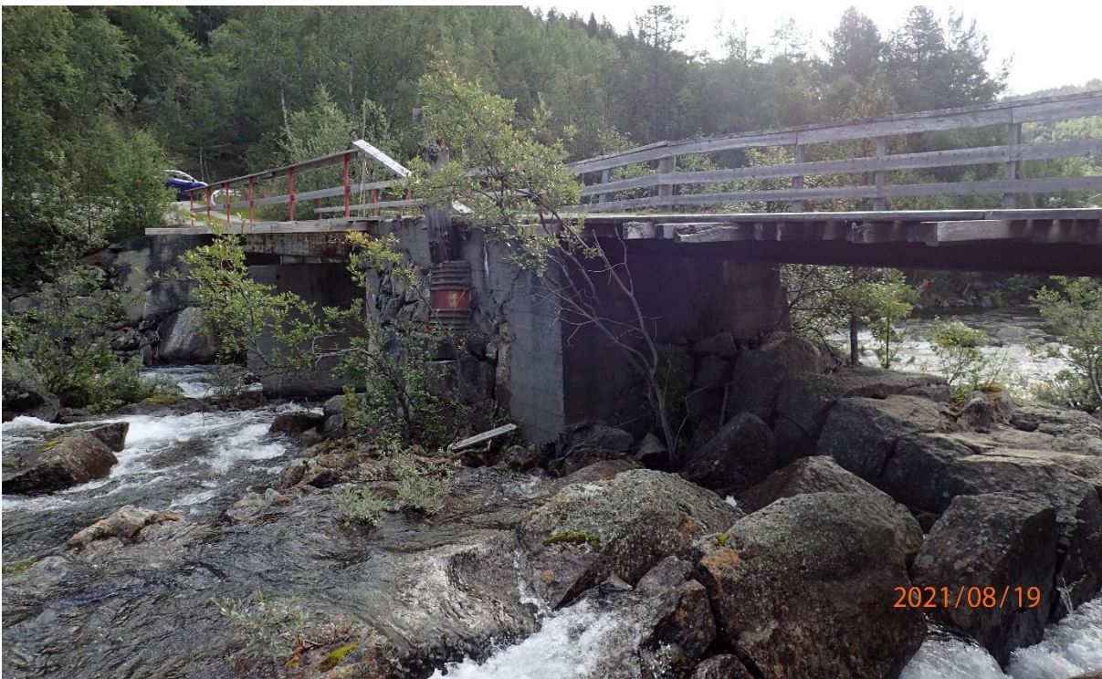
Figur 1-10 Bru 2 nord for Flothyneset, oppstrøms side.
