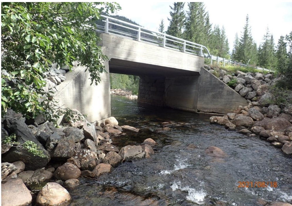
Figur 1-30 Brua Klevastaul krysser Klevastøylåi før utløpet i Kjelavassdraget.
