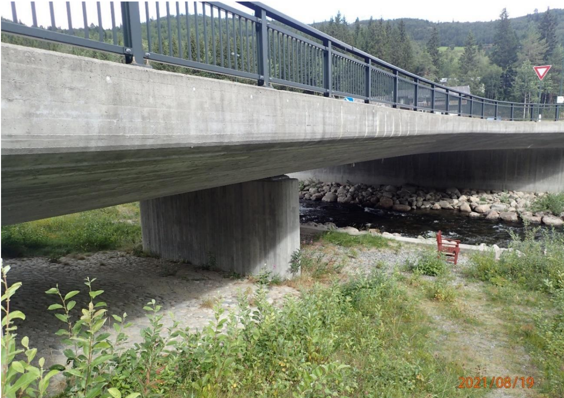
Figur 1-19 Tallaksbru nedstrøms side.
