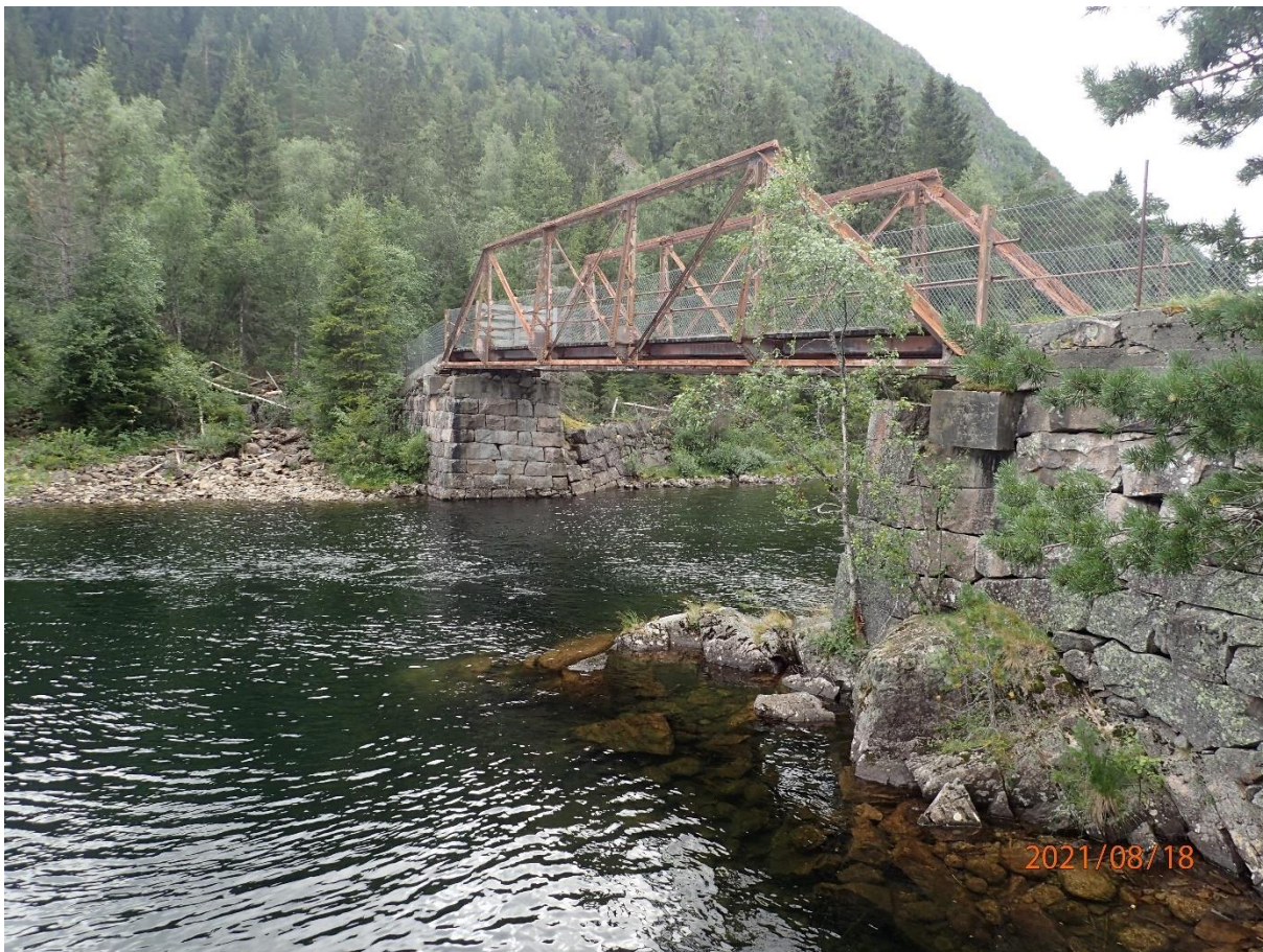
Figur 1-25 Brua mellom Tveitevatnet og Grungevatn.
