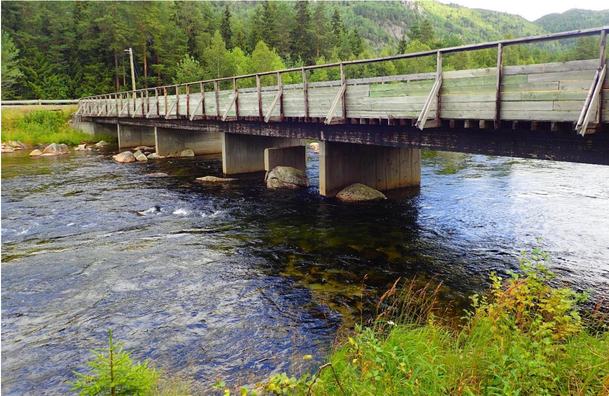
Figur 1-20 Oppstrøms side av gangbru til Haukelivegen 6003.
