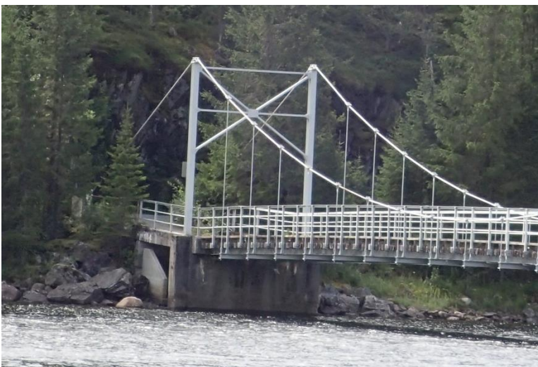
Figur 1-37 Bru over Bukkevalihylen, nedstrøms side.
