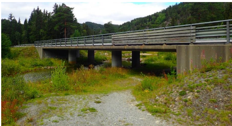
Figur 1-47 Bru Østre Bora nedstrøms side
