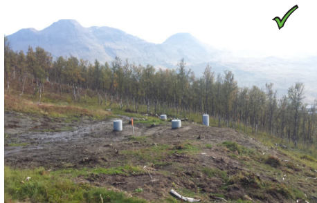
Figur 25: Toppmasser er lagt tilbake slik at naturlig revegetering kan starte. Massene er i tillegg lagt ut slik at overgang mellom omliggende terreng og punkt, blir naturtro.
