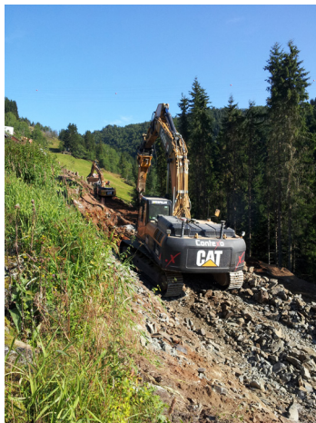
Figur 34: Opprusting av landbruksveg med stedege masser.
