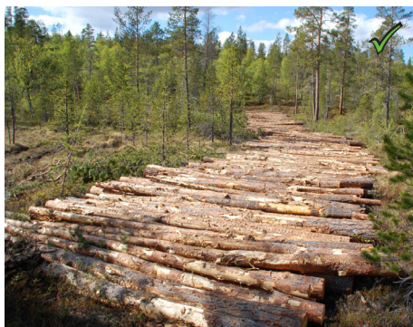
Figur 11: Eksempel på forsterket terreng i form av klogging med tommerstokker.
