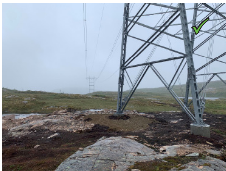
Figur 22: Her er sprengsteinsblokk fjernet fra overflaten.
