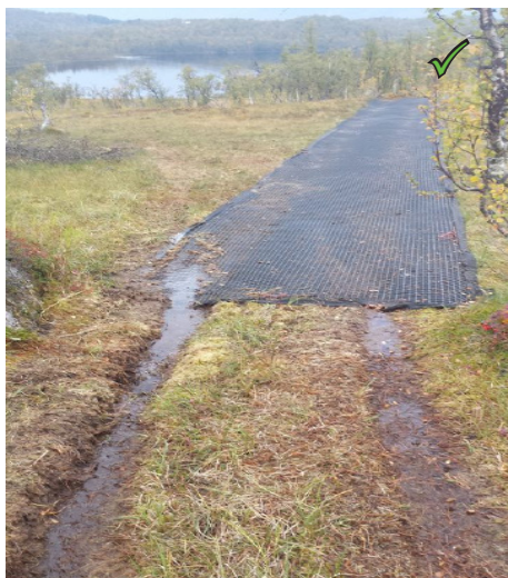
Figur 4: For å unngå kjøreskader over et bløt parti, er terrenget forsterket i forkant.
