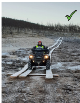
Figur 10: Eksempel på etablert terrengforsterkning over bløte partier.
