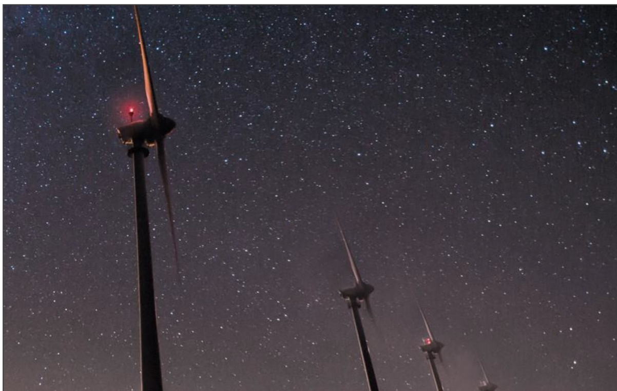
Figur 6-17. Eksempel på hinderlys på vindturbiner.
