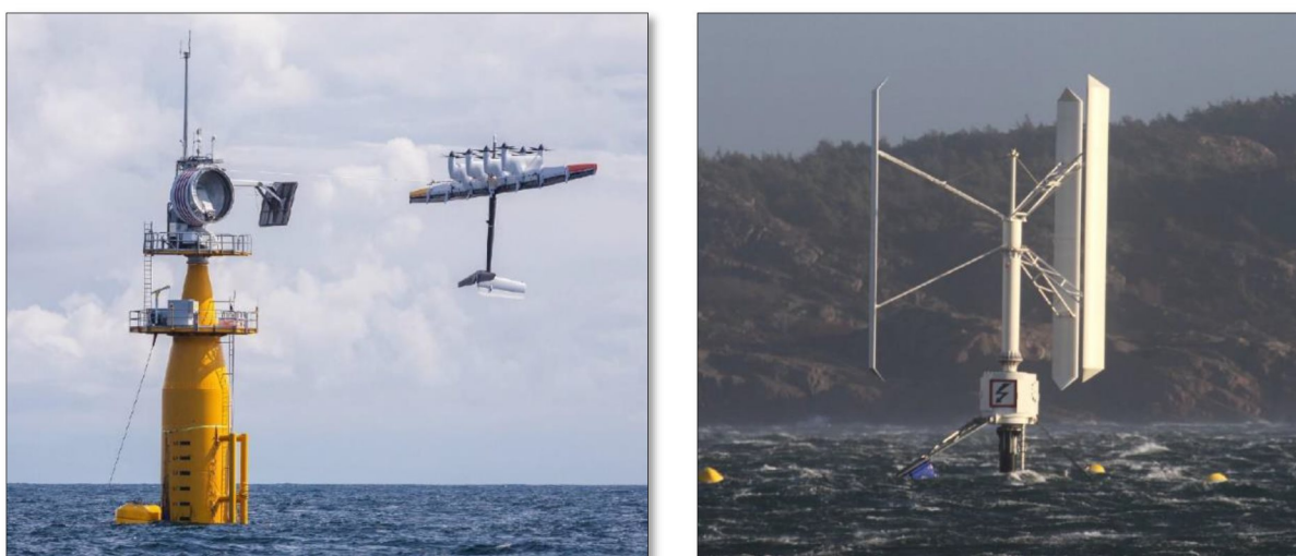
Figur 4-5. Makani flytnede vindturbin (til venstre), og SeaTwirl vertikal akse vindturbin. Kilde: METCentre.
