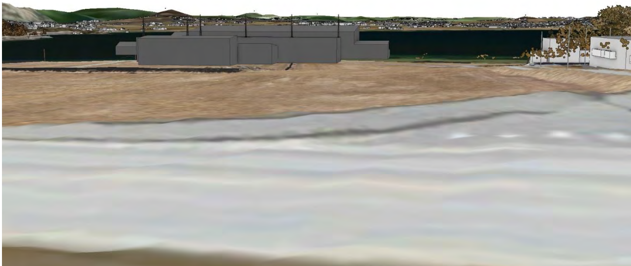
Figur 3-44 Alternativ D2, sett fra Regimentveien i nord.
