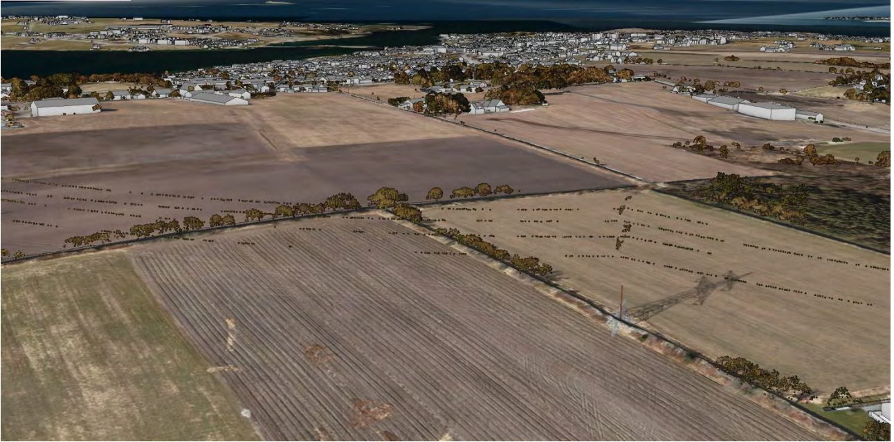
Figur 3-31 Dagens situasjon ved alternativ C2, sett fra vest.
