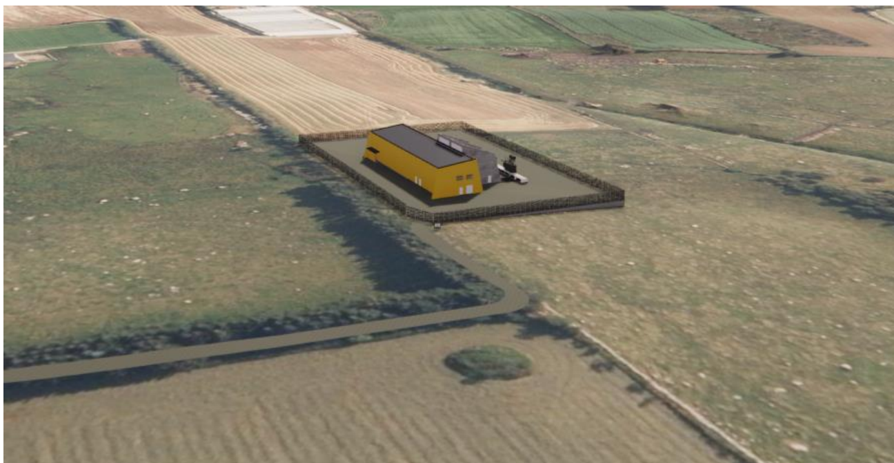
Figur 4 Tjøtta transformatorstasjon - sett fra vest
