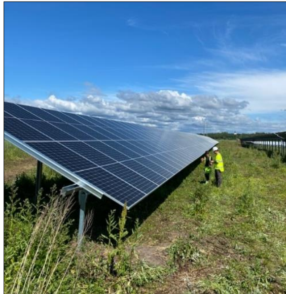
Figur 1-5: Bilde fra Solgrids 4.8 MW solkraftverk i Varberg i Sverige
