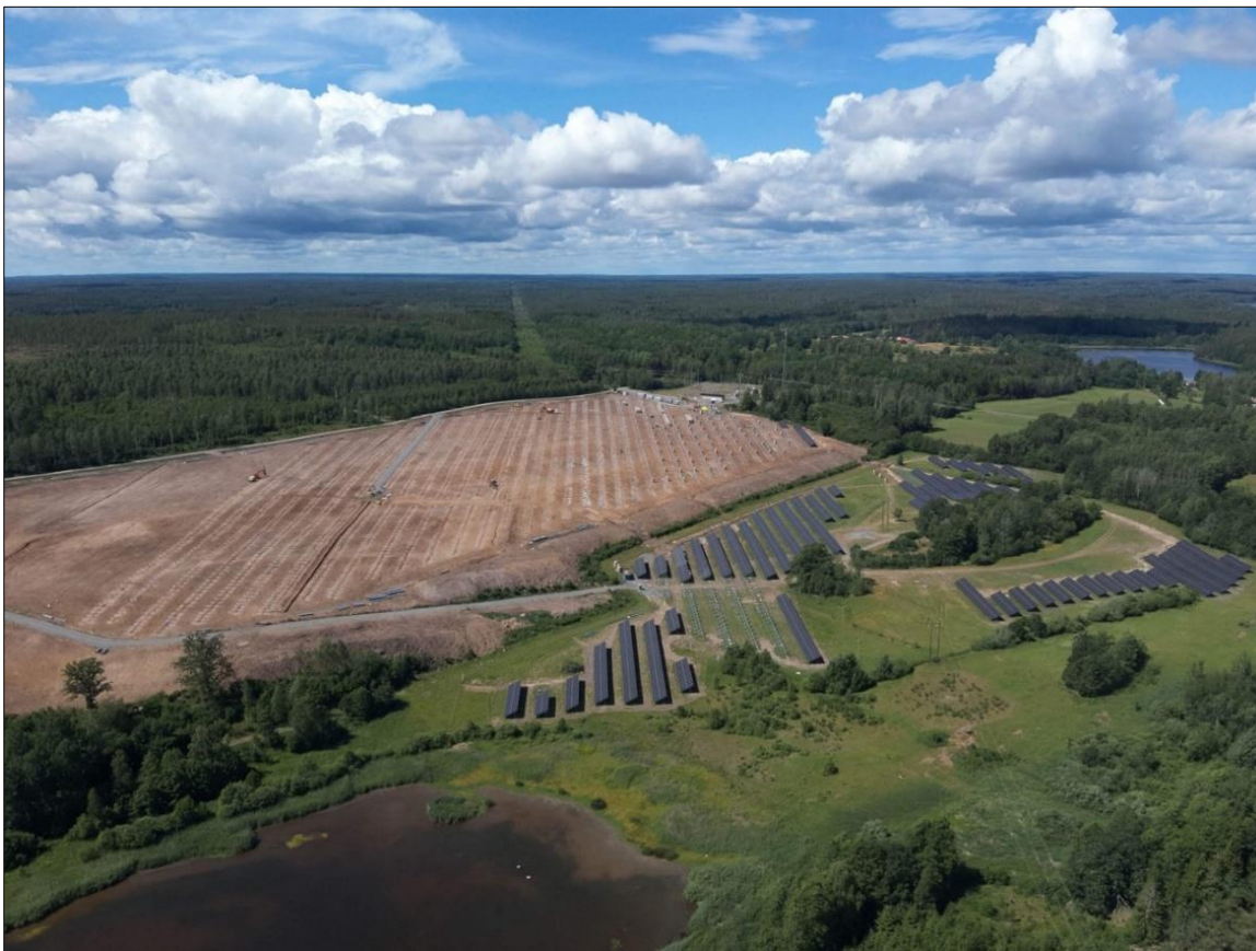
Figur 1-7: Bildet viser Mörghult solkraftverk (14,1MWp) i anleggsfasen. Dette er et av Solgrid sine prosjekter i Sverige. Til venstre i bildet er kraftverket under bygging. Til høyre i bildet er kraftverket ferdig installert.
