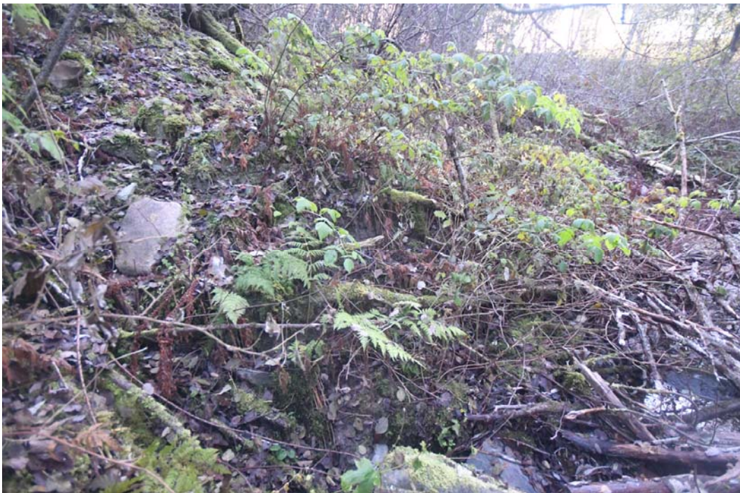
Figur 7: Små trær i elvekant veltet pga. erosjon/undergraving i innersving. Ca. 0,5 m erosjonskant.
