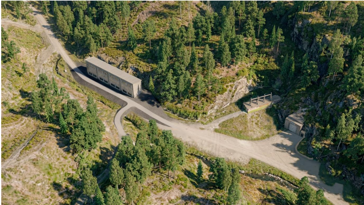
Figur 5 Illustrasjon av omsøkt tiltak (eks. ledninger). Nytt transformatorbygg. Portalen til Kaggefoss kraftverk sees til høyre.
