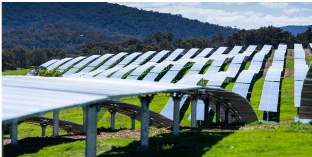
Figur 3-2. Illustrasjonsfoto fra konsesjonssøknad av én-akse systemet NX-Horizon -XTR levert av selskapet Nextracker. Foto fra Nextracker.
