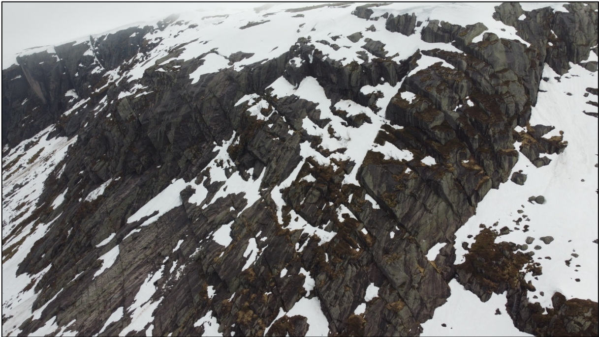
Figur 24: Berget i den sørlige dalsiden er relativt massivt, men med noe oppsprekking langs både et eksfoliasjonsplan og langs tilnærmet vertikale sprekker.
