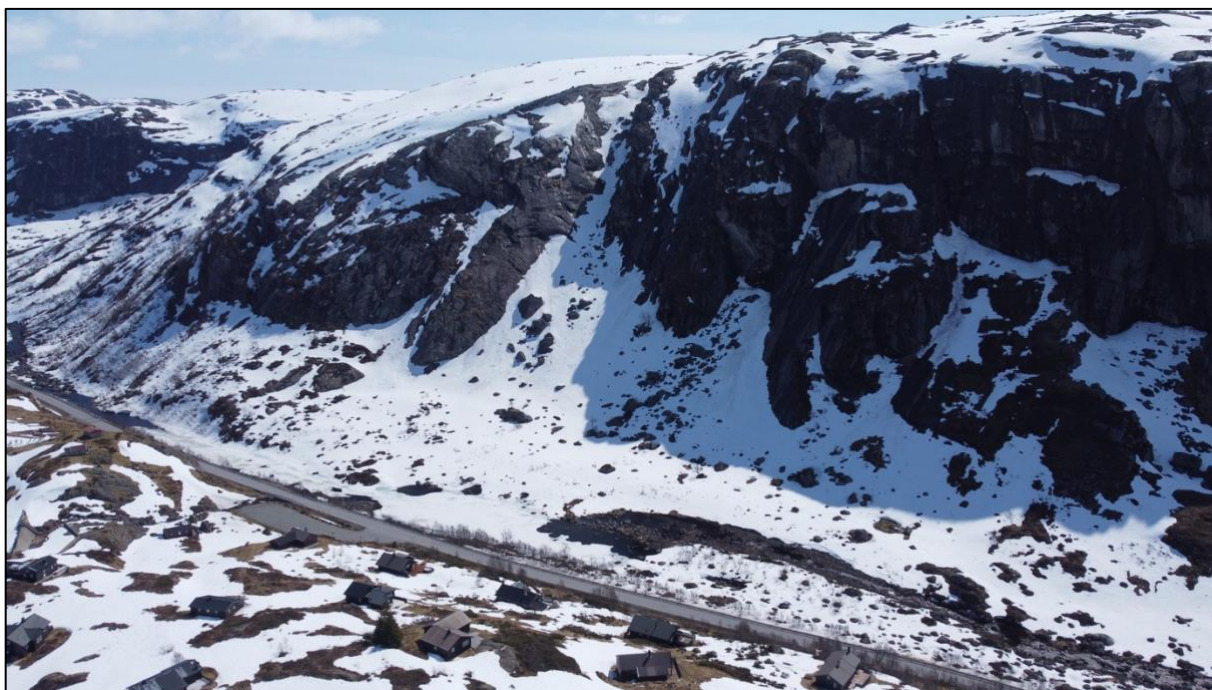
Figur 4: Lengst øst i den sørlige skråningen er det observert noe steinsprangavsetninger.
