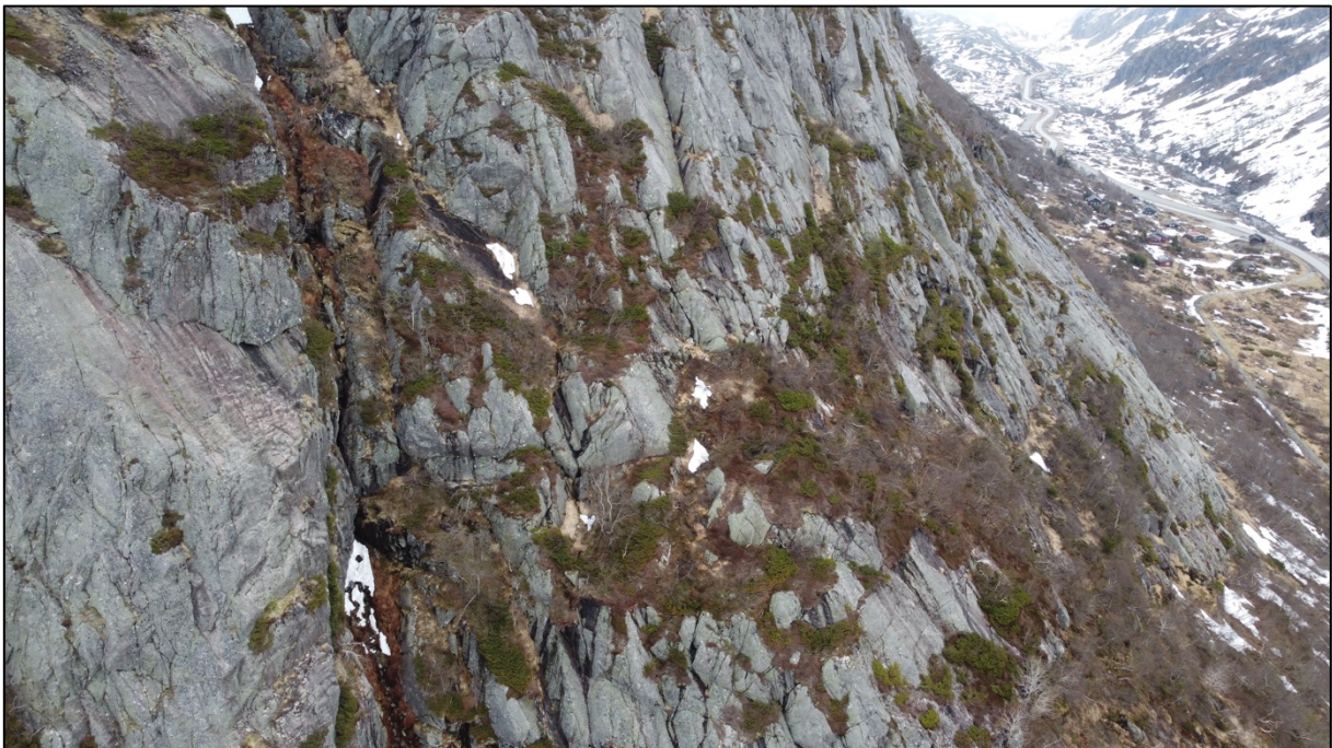
Figur 25: Berget nordøst for kartleggingsområdet er ganske massivt, med forholdsvis få sprekkeavgrensede blokker.
