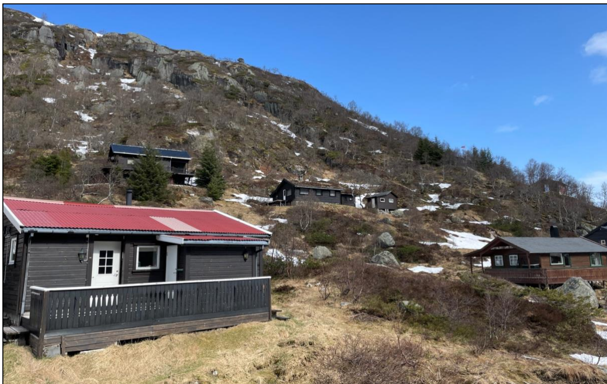
Figur 5: Lengst vest i området er det observert en del blokk blant hyttene i den nordlige dalsiden. Opphavet til blokkene er usikkert.
