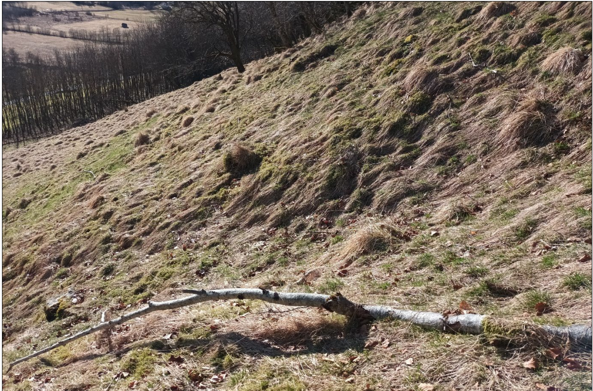
Figur 10: Øvre del av terrenget nedanfor fjellskrenten er småkupert av små opphevingar og nedsenkingar i terrenget, tolka å vere gamle skredvifter. Infopunkt 3.
