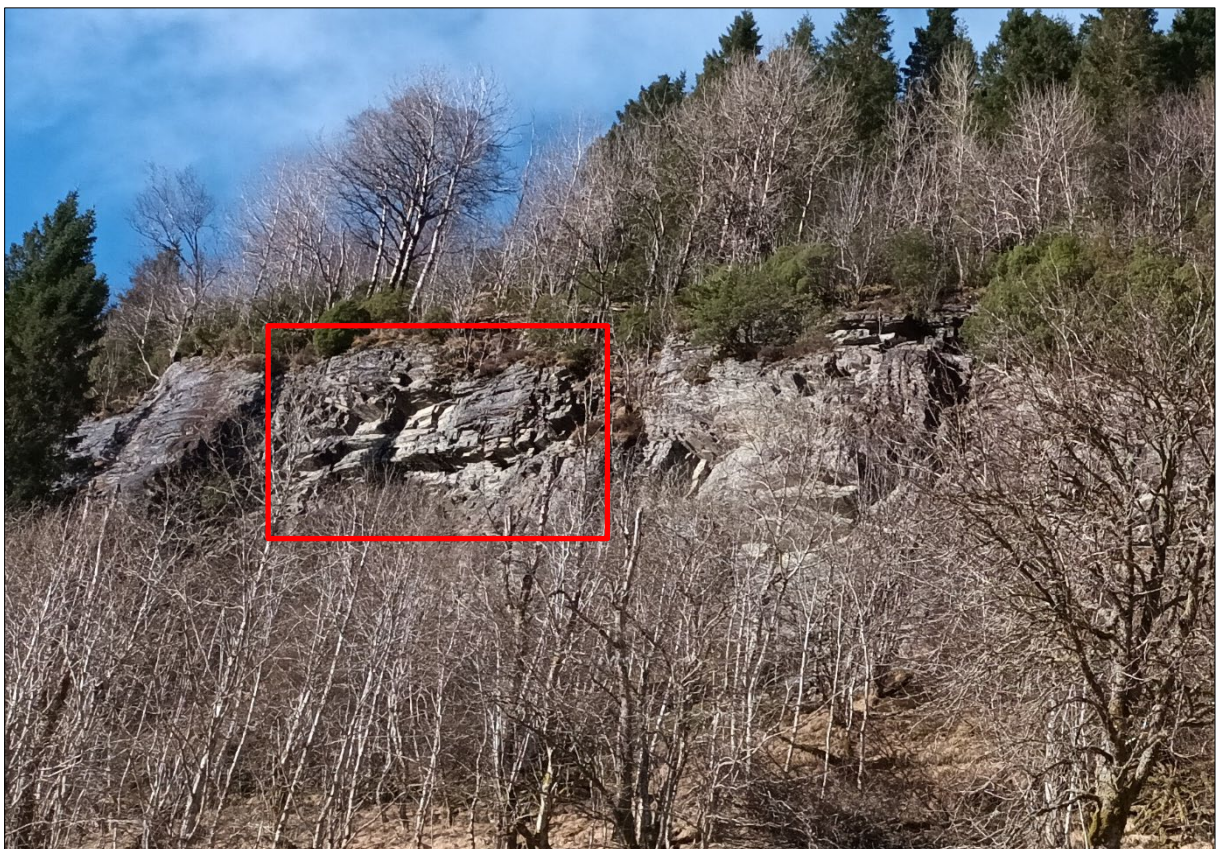
Figur 8: Øvre del av fjellskrenten har høy sprekkdanning langs foliasjonsplana, noko som har danna fleire små overheng (markert med raudt omriss). Det er vertikale sprekkesett med varierende sprekkavstand frå 10 – 20 cm opp til over 2 meter.
