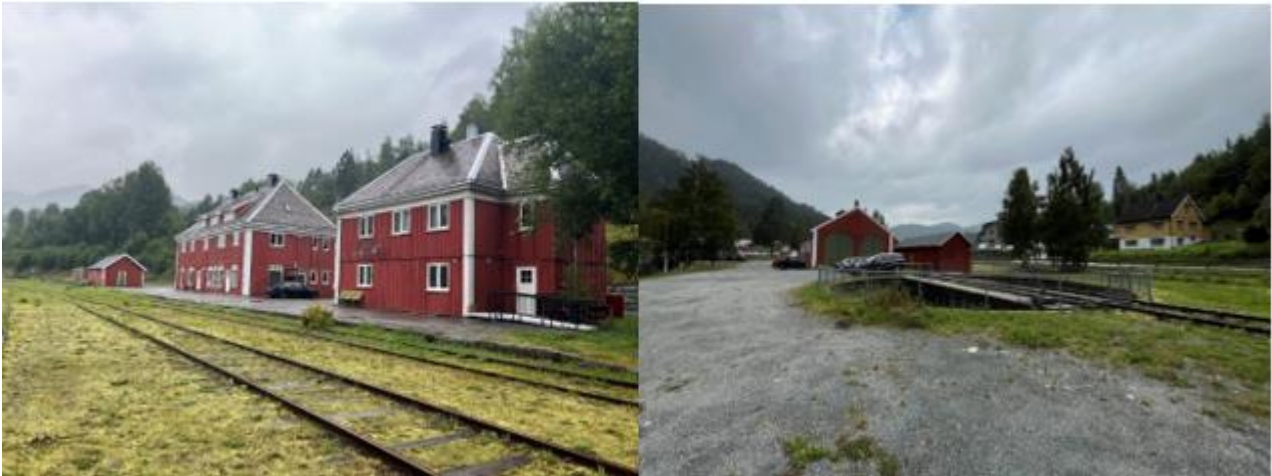
Figur 4-19 Til venstre: Godsbygning (lengst til venstre), stasjonsbygning (i midten) og tjenestebolig (til høyre) sett mot nordvest. Til høyre: Lokomotivstallen (bygningen med grønne dører) og vedbuen (til høyre). Den runde strukturen foran bygningene er en gammel svingskive. Alle kulturminner er forskriftfredete. Foto tatt mot sør-sørvest.
