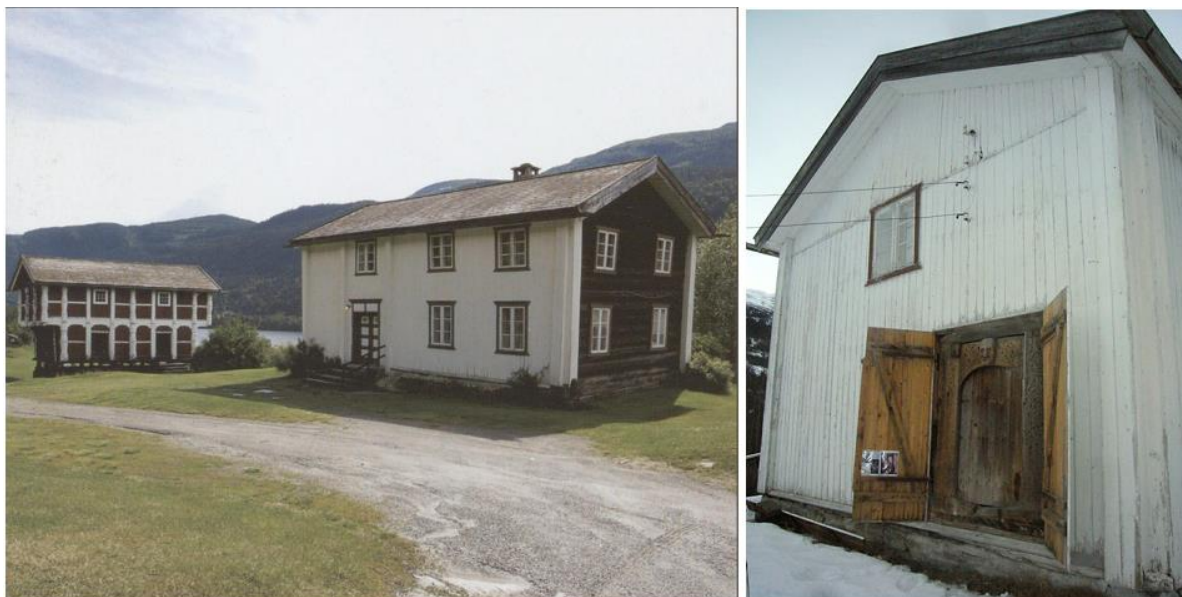
Figur 4-48 Til venstre: stabbur (Askeladden ID 85546-1) og våningshus (85546-2) på Mellom-Kravik. Våningshuset antas å være Norges eldste bebodde hus [29]. Til høyre: Den såkalte Kravik-portalen i våningshusets sørvegg. Kilde: Riksantikvaren
