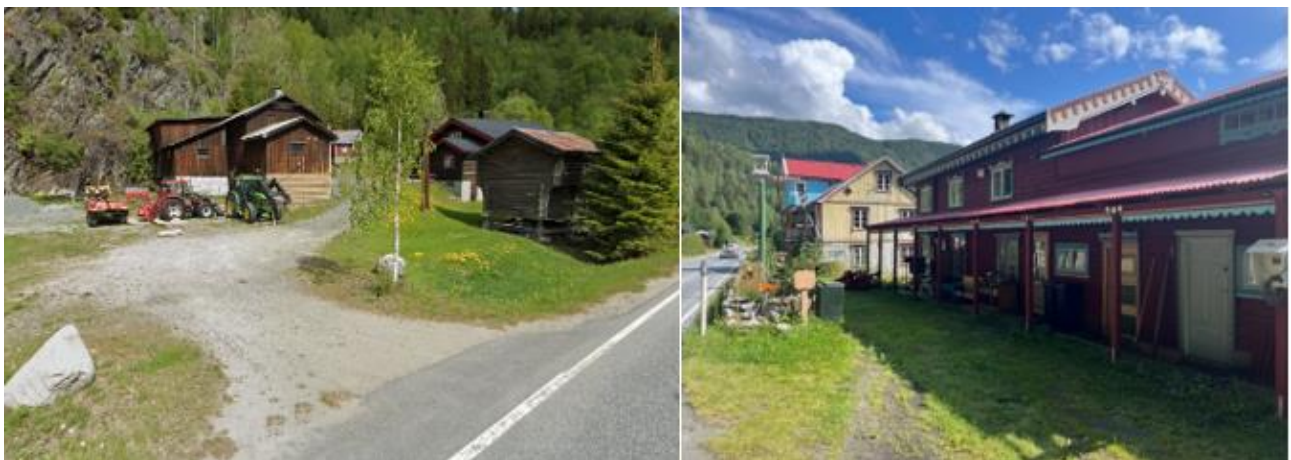
Figur 4-32 Nedre Sporan med SEFRAK-registrert stabbur, våningshus, badstu og stue. Sett fra Norevegen, tatt mot nordøst. Huset til venstre er et nyere tillegg til gården. Til høyre: Bygningene på Strøm sett mot øst.
