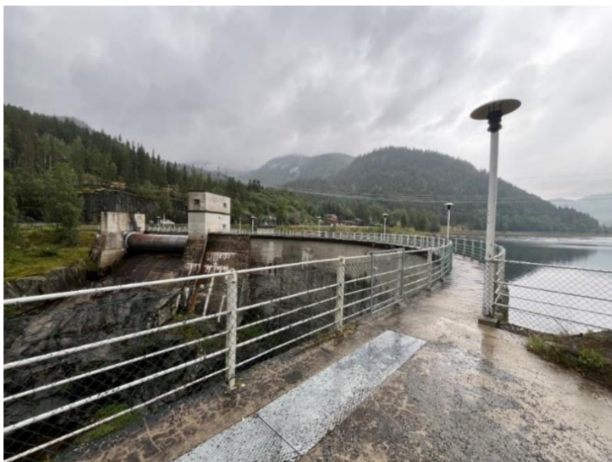
Figur 4-17 Rødbergdammen fotografert mot øst.
