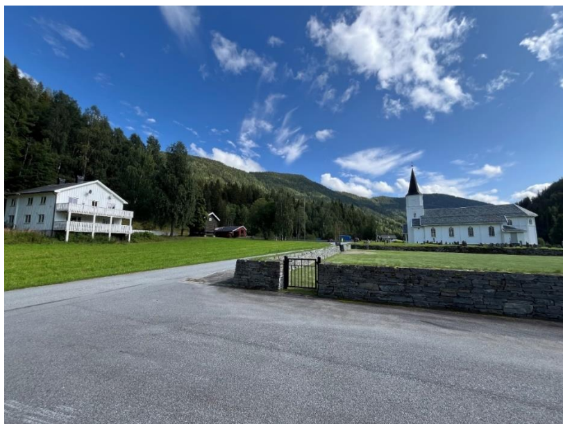
Figur 4-34 Skjønne kirke (Askeladden ID 85467) og SEFRAK-registrert stabbur (SEFRAK ID 0633-0008-199) ved trærne til venstre på bildet. Kokegropfeltet (Askeladden ID 91487) ligger ca. i forgrunnen under det asfalterte området. Foto tatt mot sørøst.
