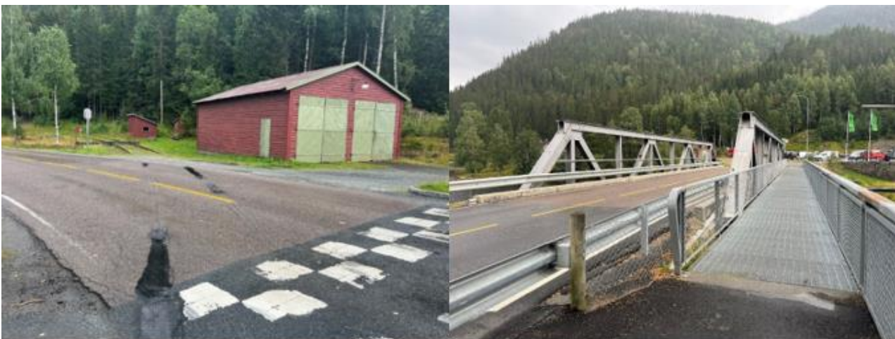
Figur 4-20 Til venstre: Liten lokomotivhall, gammelt signalanlegg og jernbaneskinnen som er delvis overasfaltert. Foto tatt mot sørøst. Til høyre: Bruen som går over Uvdalselva. Den er forskriftfredet og ble bygget i forbindelse med jernbaneutbyggingen. Foto tatt mot sør.
