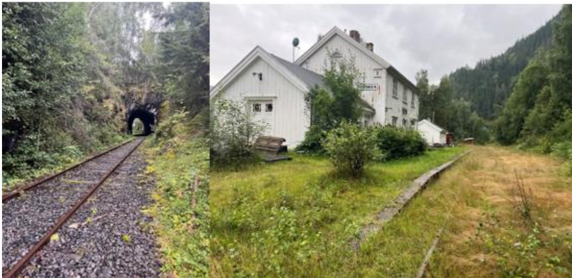
Figur 4-21 Til venstre: Nummedalsbanen slik det fremstår utenfor Rødberg. Banen er enkelte steder helt overgrodd av vegetasjonen, men det er mulig å sykle med dresin på deler av strekninger. Banen går ofte i tunneler. Foto tatt mot nord. Til høyre: Gammel Gvammen stasjon og jernbaneskinnen forbi. Tatt mot sør-sørvest.
