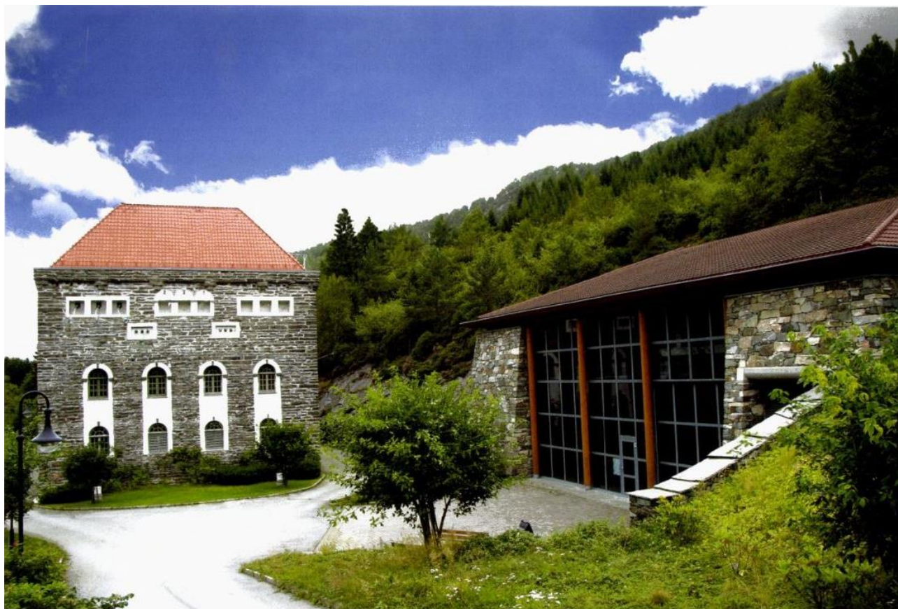
Figur 7-1 Den gamle (til venstre) og den nye kraftstasjonen på Herlandsfoss på Osterøy. Det nye kraftverket er reist i lignende stil og ved bruk av samme byggemateriale. Lignende utføring kan anbefales for atkomstportalen for nytt Nore I kraftverk.
