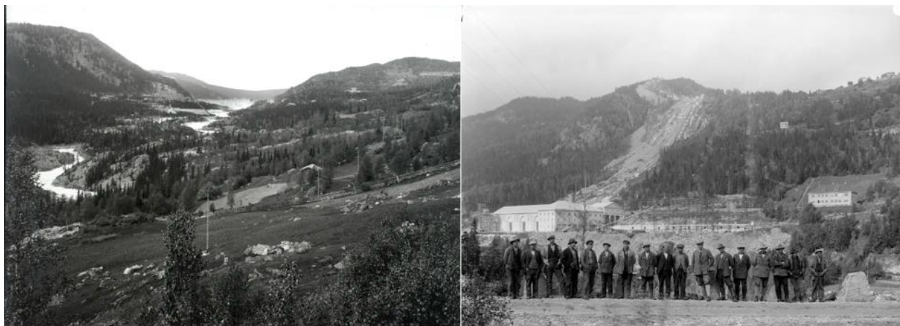
Figur 4-5 Til venstre: Tunhovddammen i bakgrunnen og en del av gårdsmiljøet i Øygardsgrend, bildet er tatt rundt 1920-1930. Kilde: Buskerud fylkesfotoarkiv. Til høyre: Arbeiderne ved anlegget Nore I kraftverk under bygging rundt 1925-1926. Til høyre vises Messebygget. Kilde: Buskerud fylkesfotoarkiv [28].
