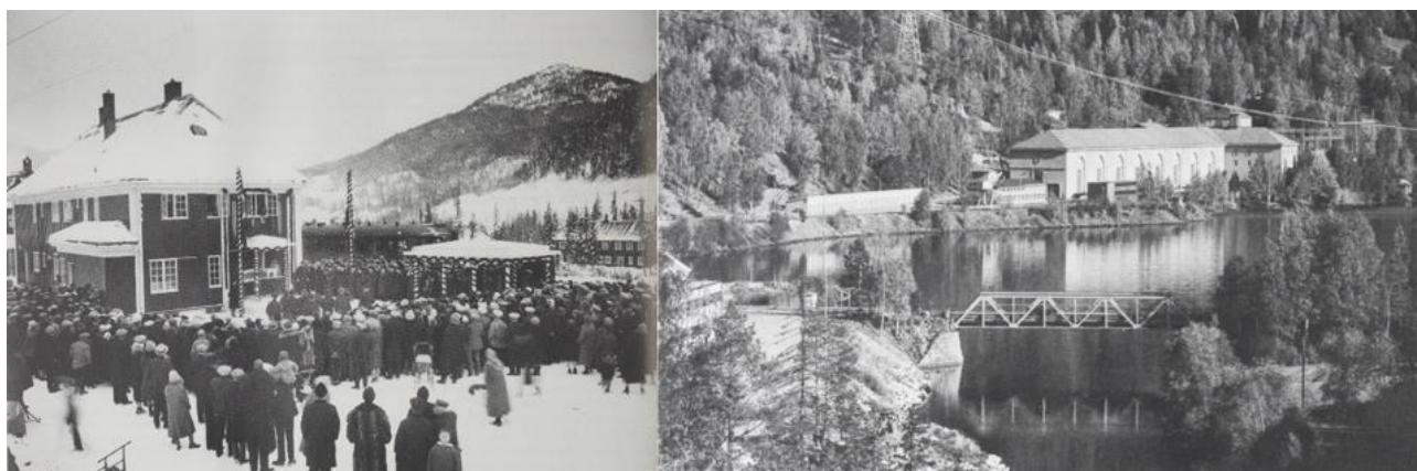
Figur 4-6 Til venstre: Åpning av Numedalsbanen i 1927. Kilde: Norsk Jernbanemuseum [28]. Til høyre: Ferdig bygget Nore I kraftverk med bruene i forgrunnen. Bruen er en del av Numedalsbanen bygget over Uvdalsåi. Kilde: Buskerud fylkesfotoarkiv [28]
