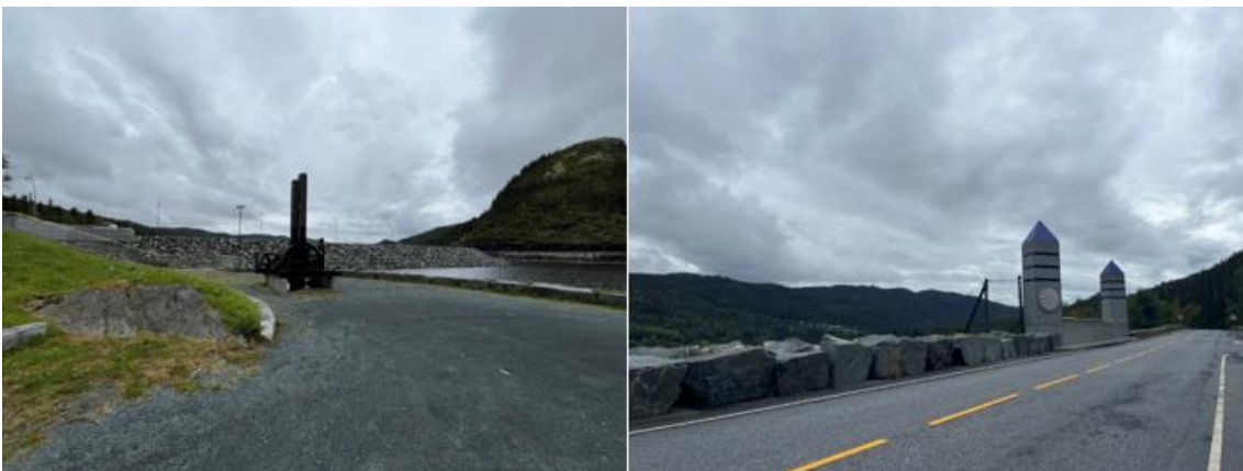
Figur 4-10 Til venstre: Nye Tunhovddammen med et gammelt lukespill foran. Sett ovenfra dammen mot sørøst. Til høyre: tårn står igjen fra byggetiden om i noe endret form. Fylkesvei 2806 går opp på dammen, bildet ble tatt derfra, mot sørøst. I bakgrunnen skimtes to-tun-gårdene (se neste kapittel 4.2.3).
