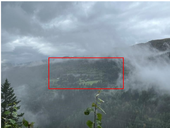
Figur 5-5 Utsikt fra delområde 3 mot Hyttatippen, mot sør-sørvest. Ved utført tiltak vil lageret med nytt riggområde og diverse anlegg enda mer synlig. Deponiet skal tømmes over tid, men dette har usikker fremgang.
