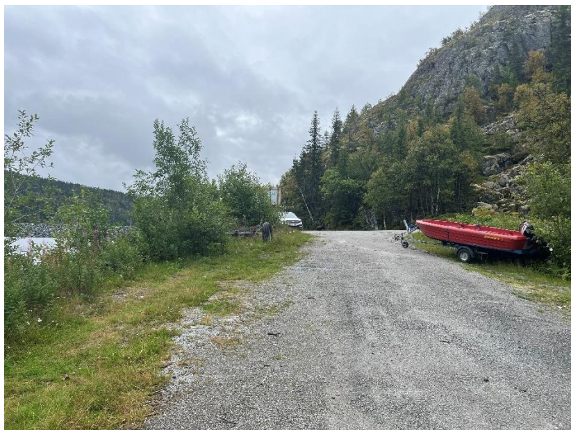
Figur 5-2 Bildet er tatt fra delområde 1 mot nytt inntak. Knausen skjærer påhugget og inntaket. Foto er tatt mot øst.
