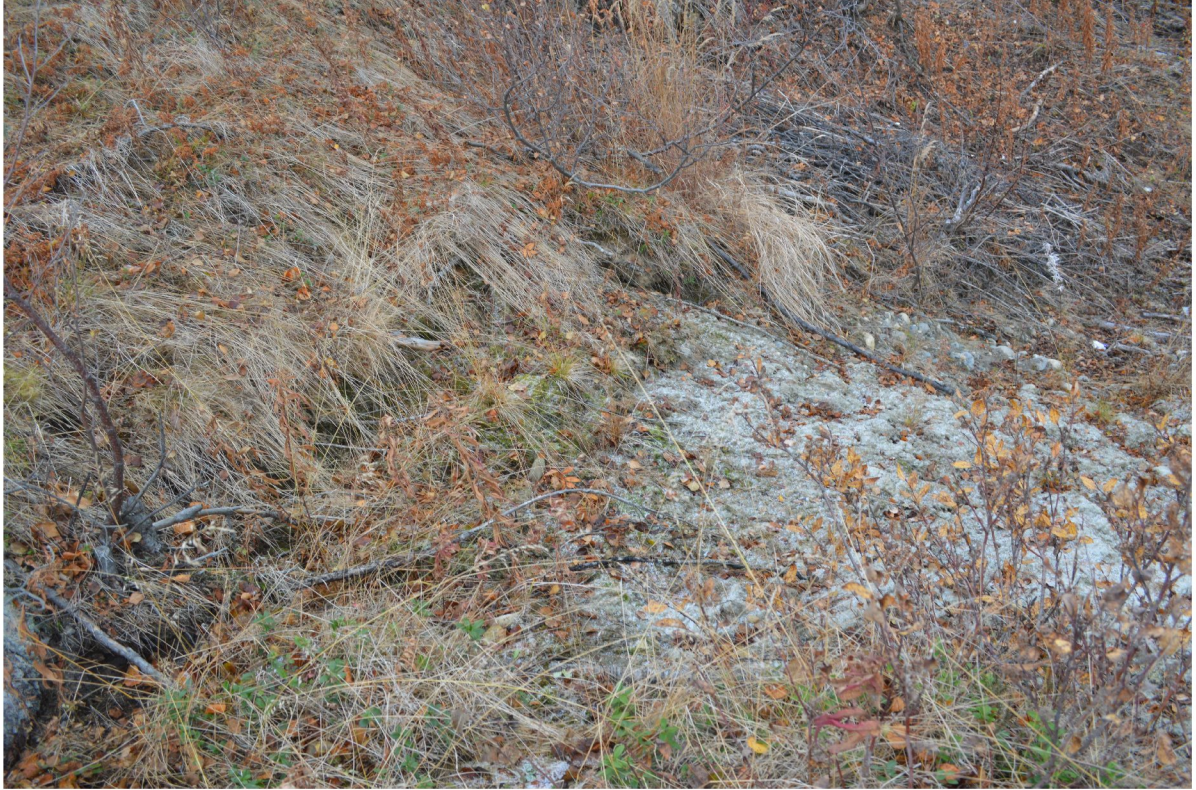
Figur 3: Utvasking i skråning, bilde tatt i ca. profil 540
