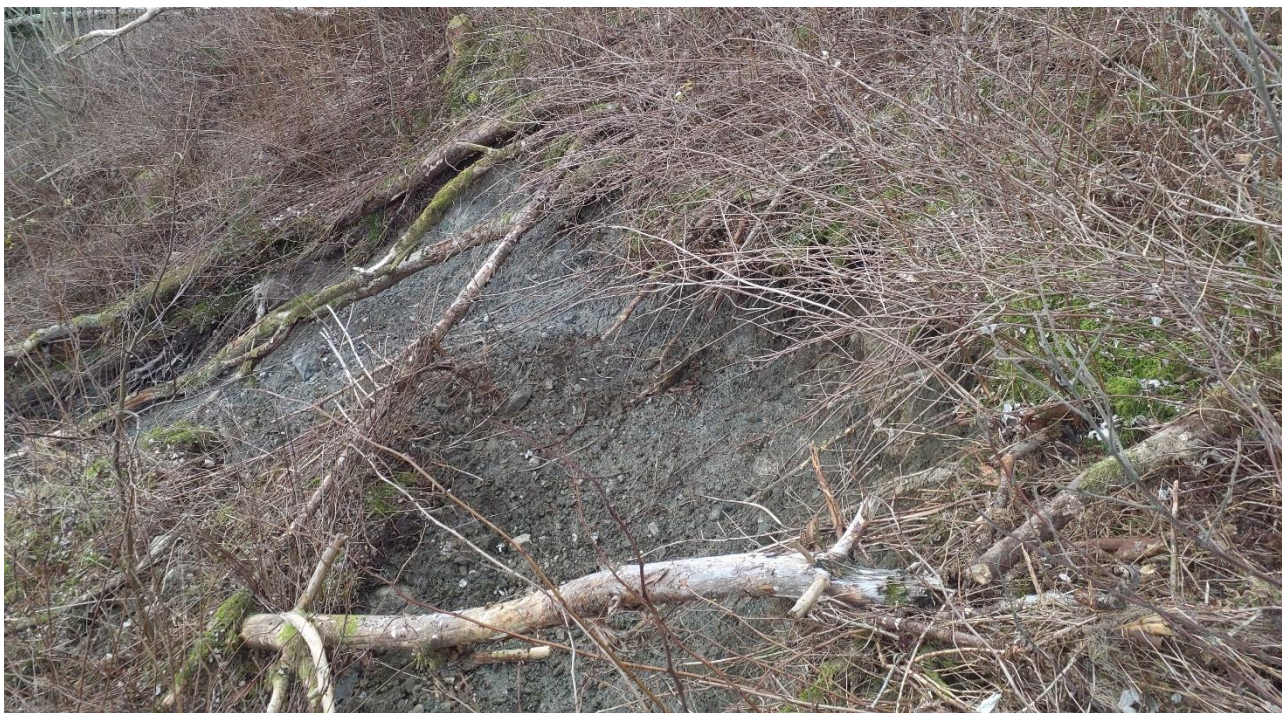
Figur 45: Under feltarbeidet ble det observert en mindre utglidning i løsmassene rett nordøst for Kaldåna, ovenfor Kvestad gård.
