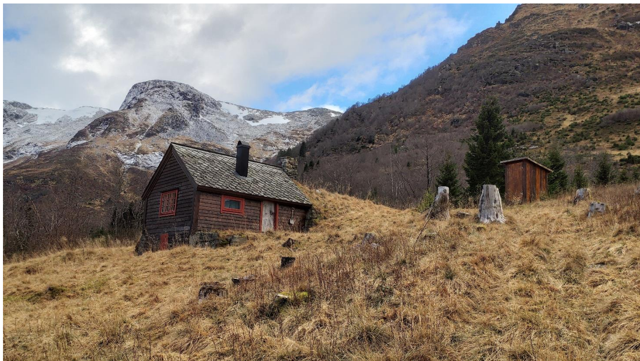
Figur 6: Etablert sikringstiltak (avskjæringsvoll) for støl ved Hersete.
