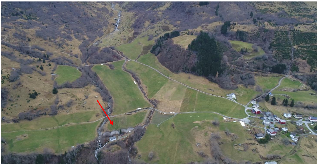
Figur 4: Dronefotogrammetri av betongmur (rød pil) med buekonstruksjon etablert etter Bleiskredet i 1994. Sikringsmuren ligger ca. 250 m sør for klyngetunet Reisetet til høyre i bildet. Dronefotoet er tatt mot vest.
