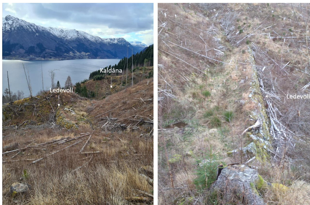
Figur 23: Ledevoll for sørpeskred som befinner vest for Kvestad, i sideravinen til Kaldåna. Tiltaket er trolig etablert grunnet sørpeskredhendelsen i 1808 (Vedlegg 7A og B, ID 6).
