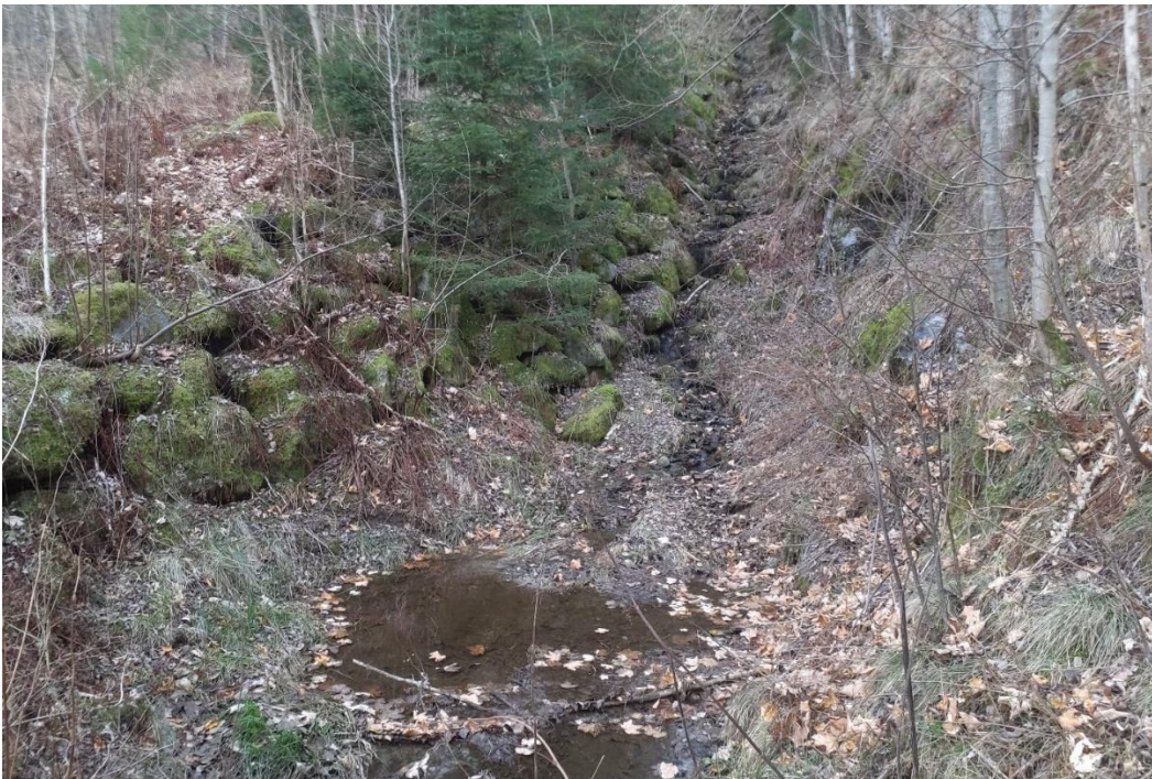
Figur 25: Ledevoll og massebasseng etablert etter flomskredhendelse 1990 (Vedlegg 7A og B, ID 47) langs bekkeløp som har løp mellom Kvestad og Haugen. Foto fra vegen mot vest.
