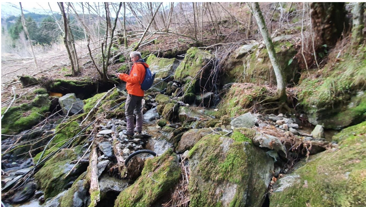
Figur 27: Foto av østligste bekkeløp (Fosseteigbekken) ved Rodgo som dreneres fra Slåttena, foto fra kote 98. Det er observert spor etter fluvial transport materiale (stein, grus og blokk) langs bekkeløpet som tyder på periodevis høy vannføring.
