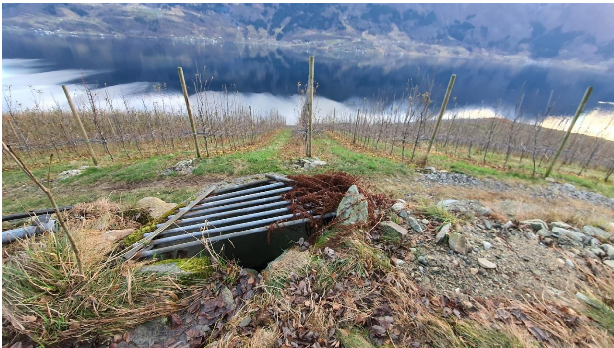
Figur 52: Bekkeløp som ledes under frukthagen ved kulvert ved kote 120. ovenfor Vikebygd sentrum.
