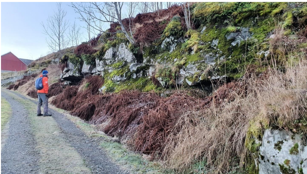
Figur 39: Flere bratte partier langs veger og boliger er sprengte fjellskjæringer. Sannsynlighet for utfall langs slike partier omfattes ikke i skredfarevurdering for bratt terreng.
