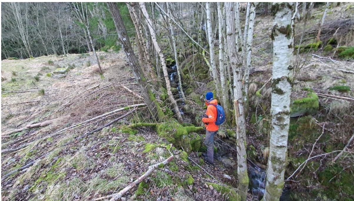
Figur 12: Noe over bebyggelsen for Skåltveit (ca. kote 220) er det etablert en ledevoll som følger bekkeløpet. Vollen har en dybde ca. 1.7 cm og lengde ca. 20-30 meter.
