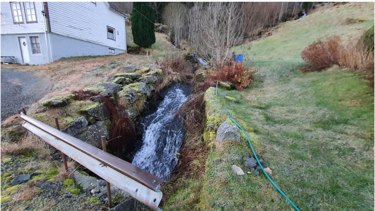
Figur 49: Bekkeløp som er omlagt ved bebyggelsen på Skåltveit. Bekkeløpet renner langs fjelloverflaten ved aktuelt område.
