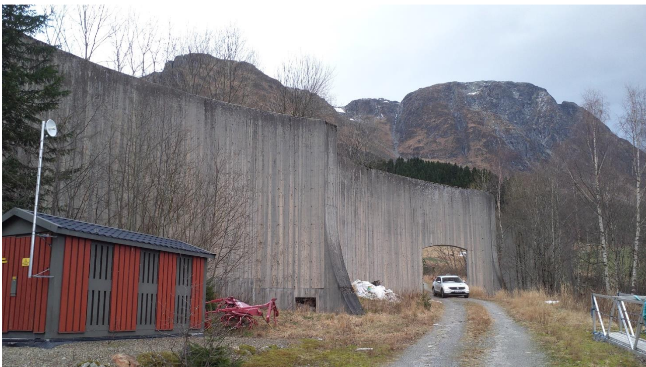
Figur 5: Nærbilde av buekonstruksjoner for sikringsmur ved Bleie.
