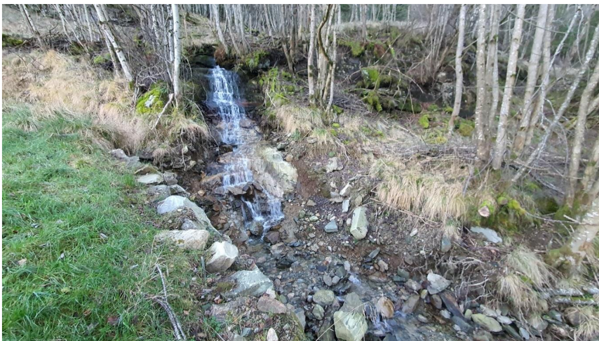
Figur 13: Langs samme bekkeløp som ledevollen (Figur 12) er det utført plastring parallelt til bekkeløpet, ca. kote 175 ovenfor Skåltveit.
