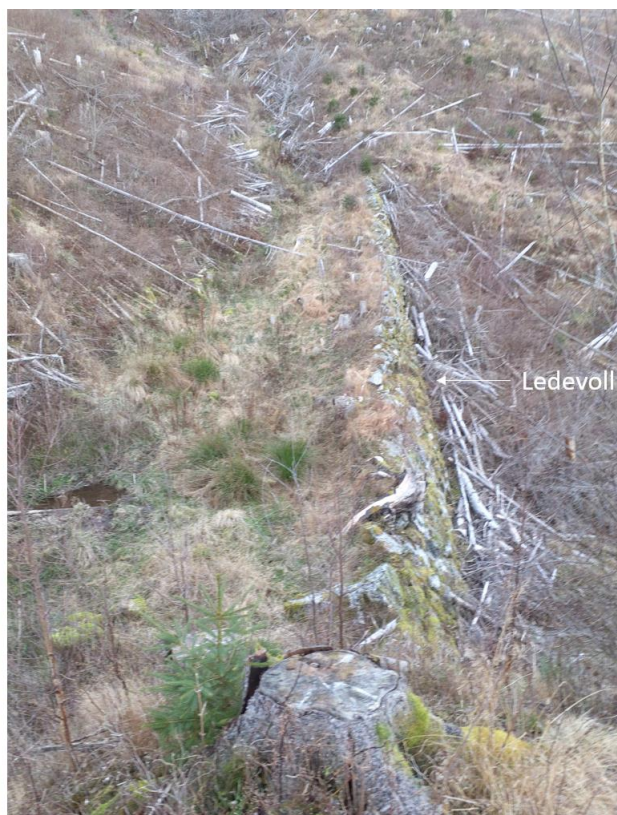
Figur 8: Ledevoll for sørpeskred som befinner vest for Kvestad, i sideravinen til Kaldåna. Tiltaket er trolig etablert grunnet sørpeskredhendelsen i 1808 (Vedlegg 7A og Vedlegg 7B: ID 6).
