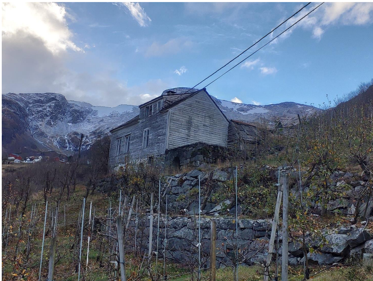
Figur 20: Bolig som det ble støpt grunnmur på for utvidelse av huset mot høyre. Huset ble ikke ferdigstilt grunnet skredfaren tilknyttet ID 2.1, Vedlegg 7B og 7A. Boligen ligger rett sørøst for Reisetvegen 94.
