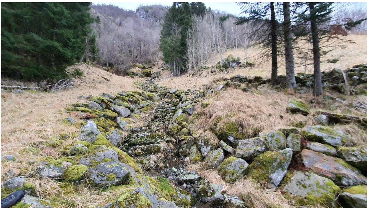
Figur 31: Foto av vestlig bekkeløp som kommer ned fra Stølen. Foto tatt mot nordvest ved kote 280. Det er utført tiltak langs bekkeløpet med plastring, samt er det etablert en ledevoll i ytterkanten som grenser mot bebyggelsen.
