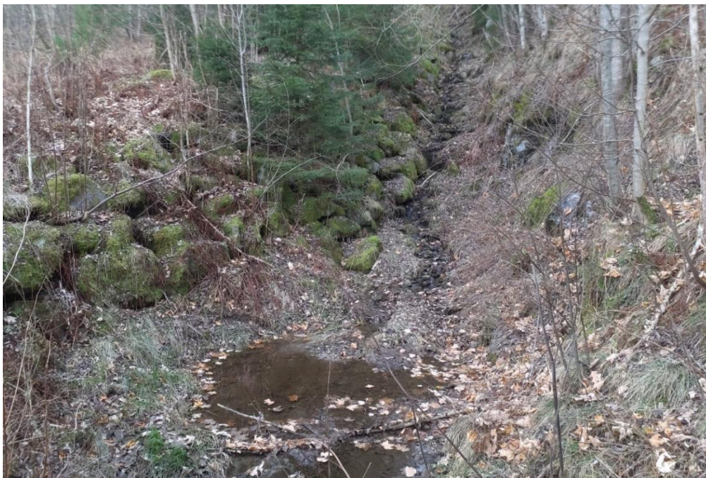
Figur 10: Ledevoll og massebasseng etablert etter flomskredhendelse 1990 (Vedlegg 7A og Vedlegg 7B: ID 47) langs bekkeløp som har løp mellom Kvestad og Haugen. Foto fra vegen mot vest.
