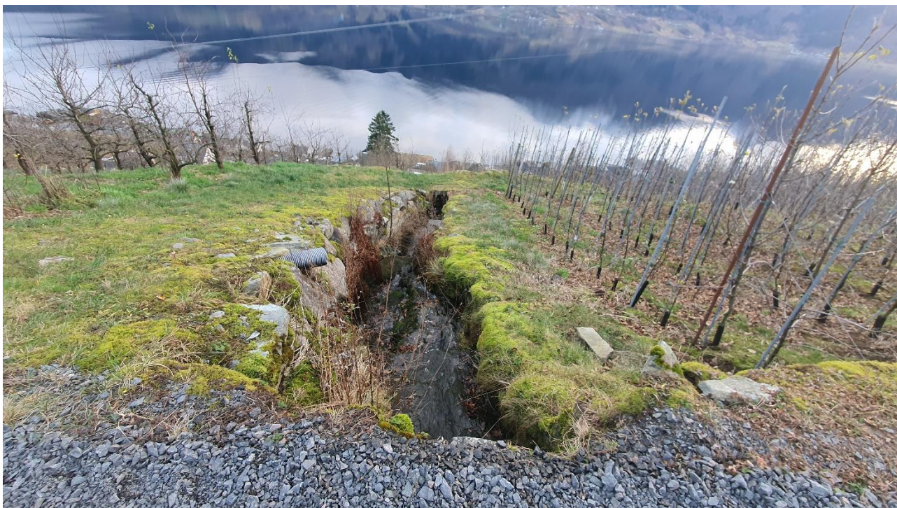
Figur 51: Bekkeløp som ledes under traktorveg ved kote 85, ovenfor Vikebygd sentrum. Parallelt til bekkeløpet er det etablert steinmur, trolig for å hindre erosjon.
