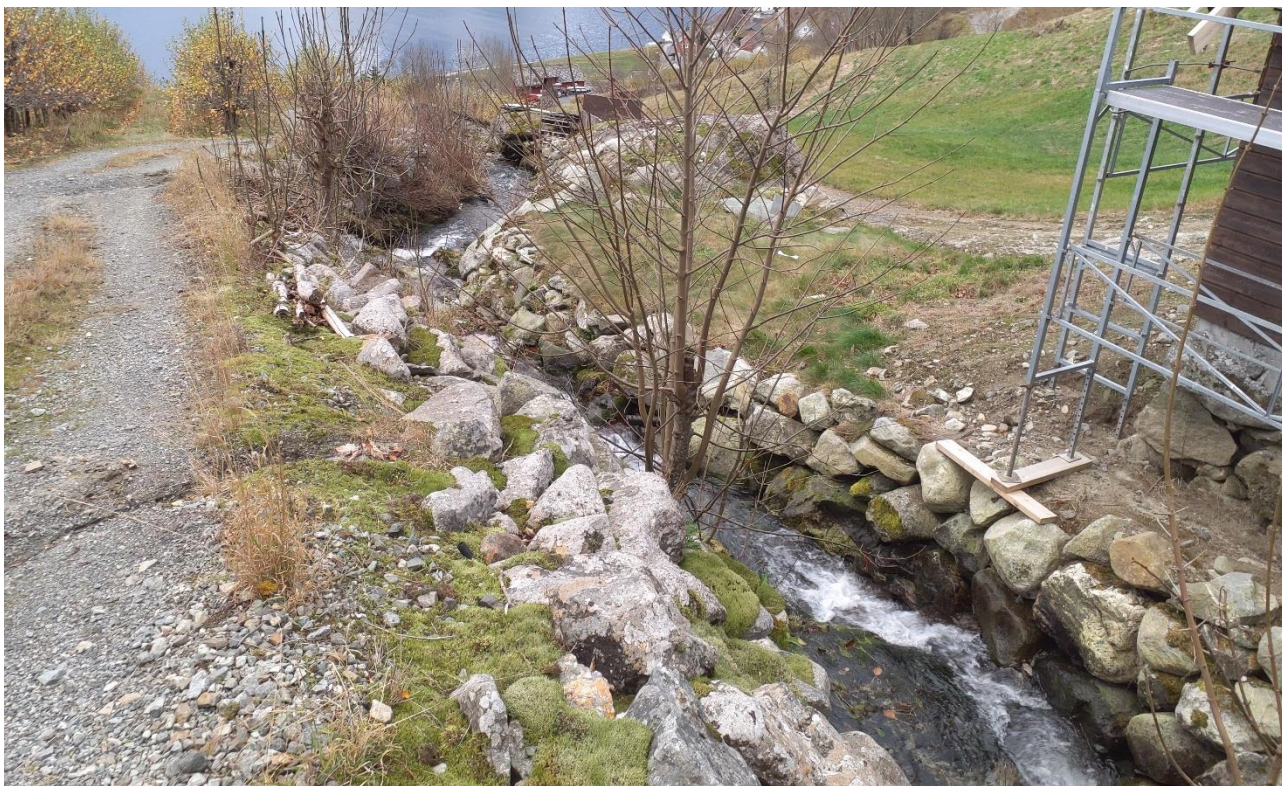
Figur 56: Det er langs nedre del av bekkeløpet som kommer ned mellom Midtre Bleie og Ytre Bleie etabler plastring med stein parallelt til bekkeløpet. Foto fra kote 40.
