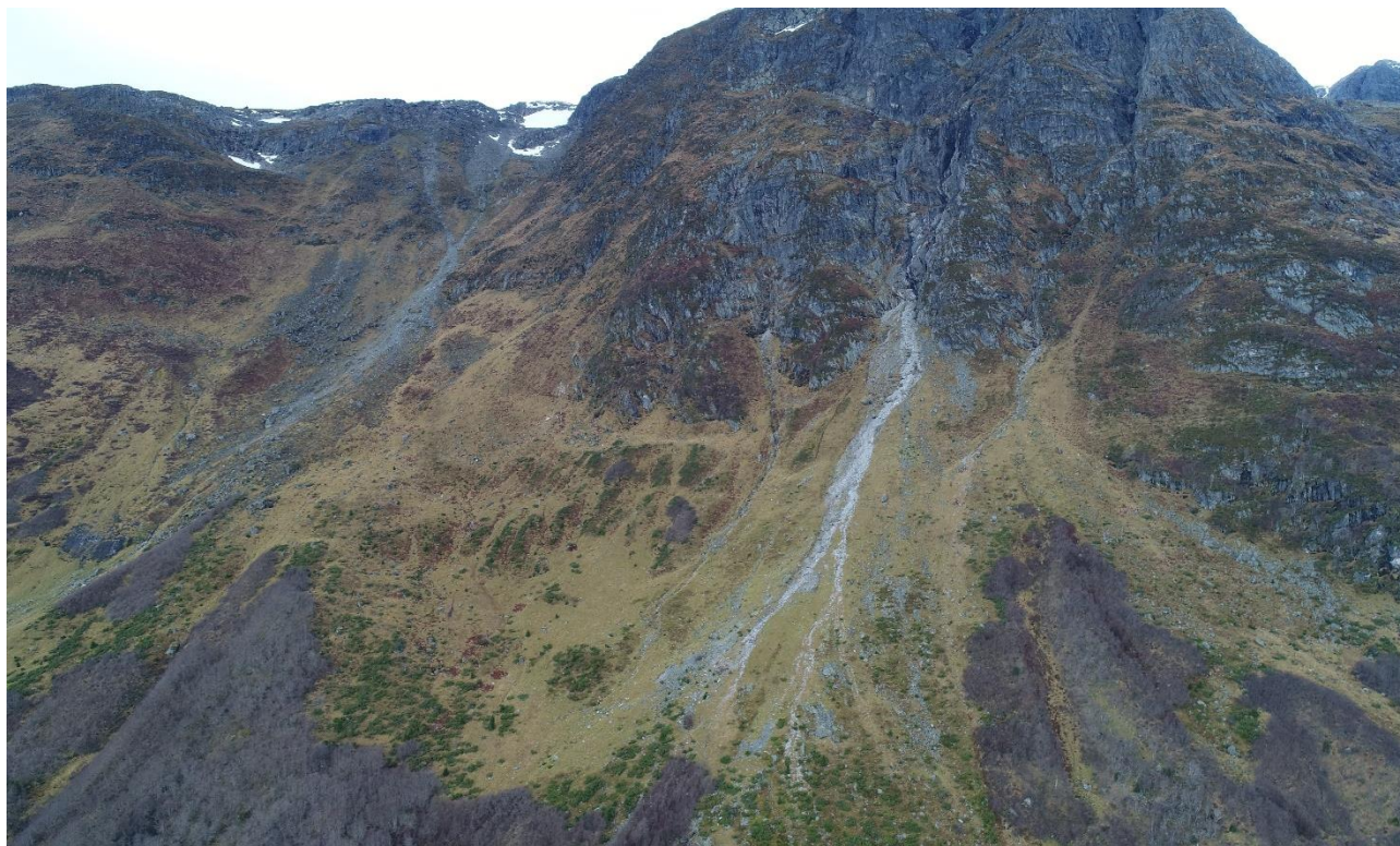
Figur 35: Nærbilde av viftesystemene under Hersetenuten (venstre i bildet) og Gråsteinsnuten (høyre i bildet). Det er spor etter både steinsprang, flomskred og snøskredavsetning langs gjelene.
