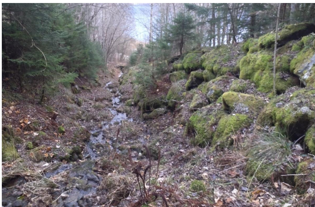
Figur 9: Ledevoll etablert etter flomskredhendelse 1990 (Vedlegg 7A og Vedlegg 7B: ID 47) langs bekkeløp som har løp mellom Kvestad og Haugen. Foto mot sørøst.
