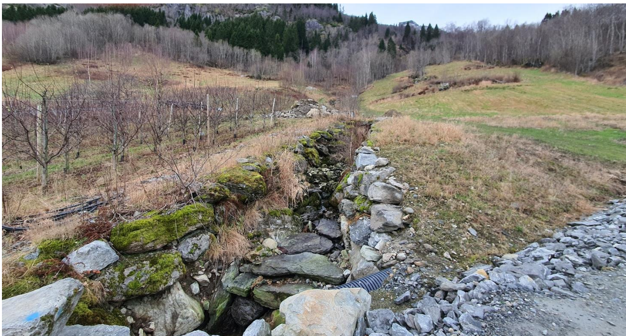
Figur 30: Foto av midterste bekkeløp som kommer fra Ugjerdsla rett øst for klyngetunet. Foto tatt mot nordvest ved kote 264.
