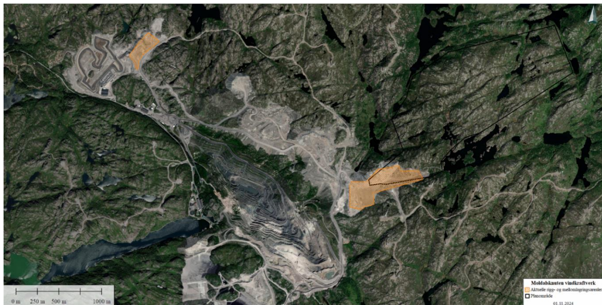
Figur 3-6 Ortofoto med angivelse av aktuelle områder for riggplass og mellomlagring
