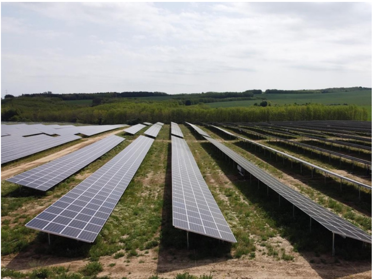
Figur 3-3 Visualisering av solkraftverk med fast vinkel. kilde Zimmerman PV-Steel GmbH og Co.
