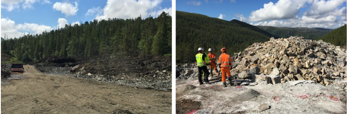
Figur 3-2 Anleggsarbeider ved tilrettelegging for beite, massehåndtering og sortering av forskjellige steinstørrelse. kilde Multiconsult.
