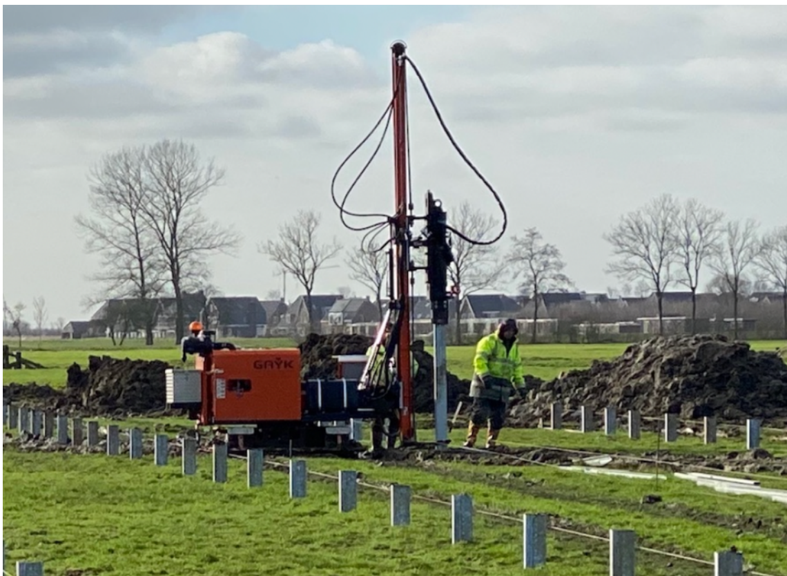
Figur 2-5 Eksempel på pælemaskin for fundamentet fra konstruksjonen av Energeias solkraftverk i Nederland.
