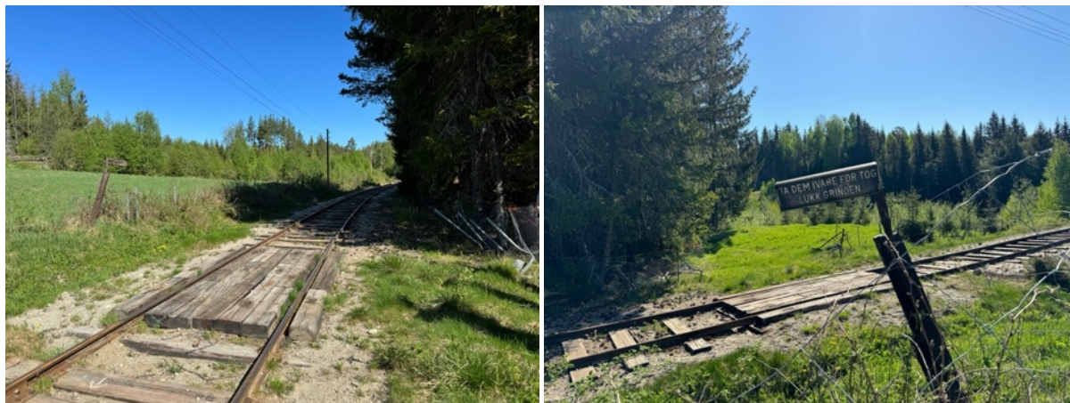
Figur 2-10 Kryssing av Krøderbanen
