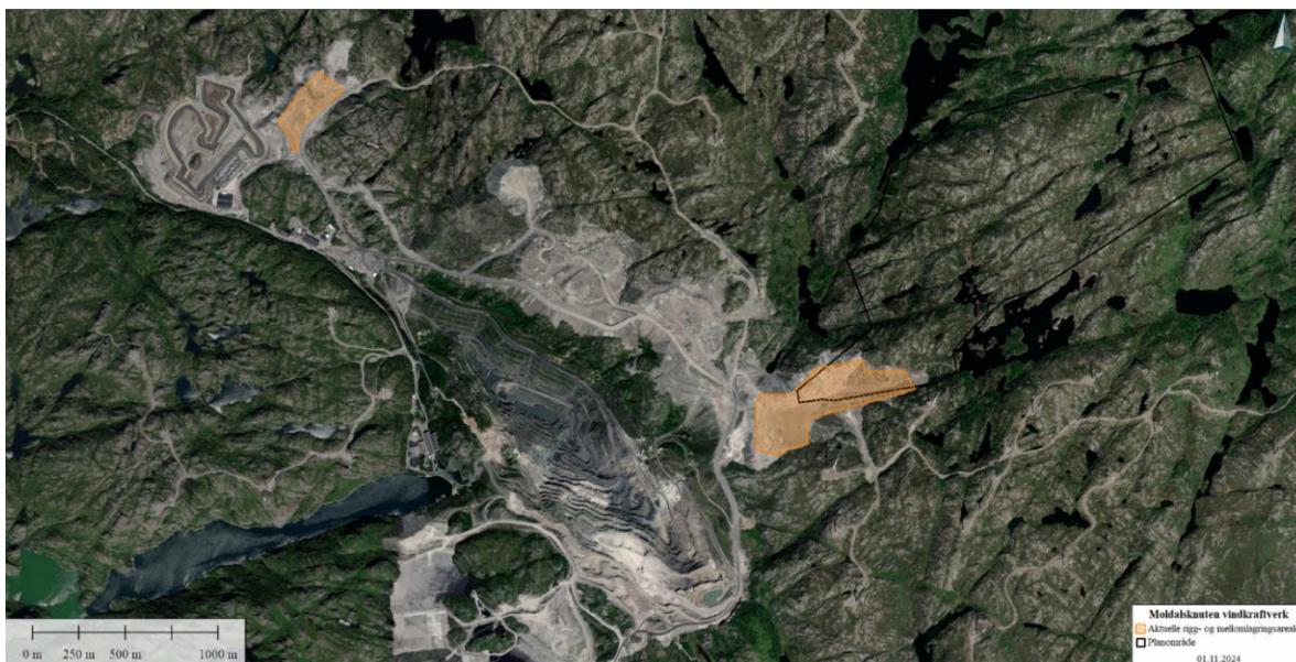
Figur 3-6 Ortofoto med angivelse av aktuelle områder for riggplass og mellomlagring
