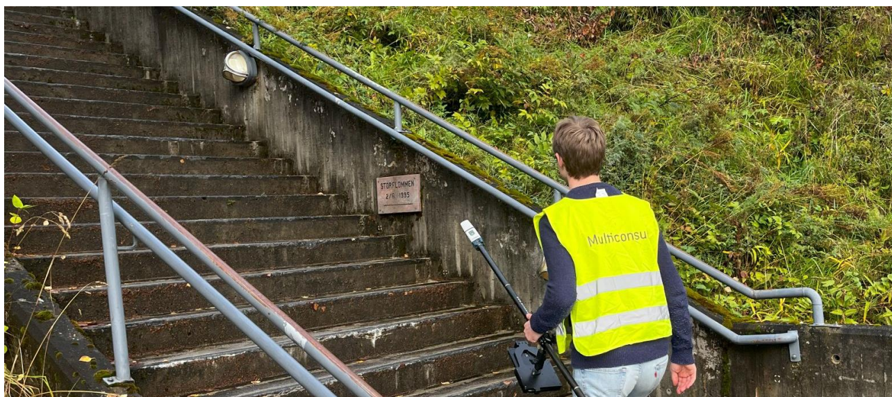
Figur 3-1: Vannmerke fra 1995-flommen i trappegangen mellom Brugata og Telthusveien
