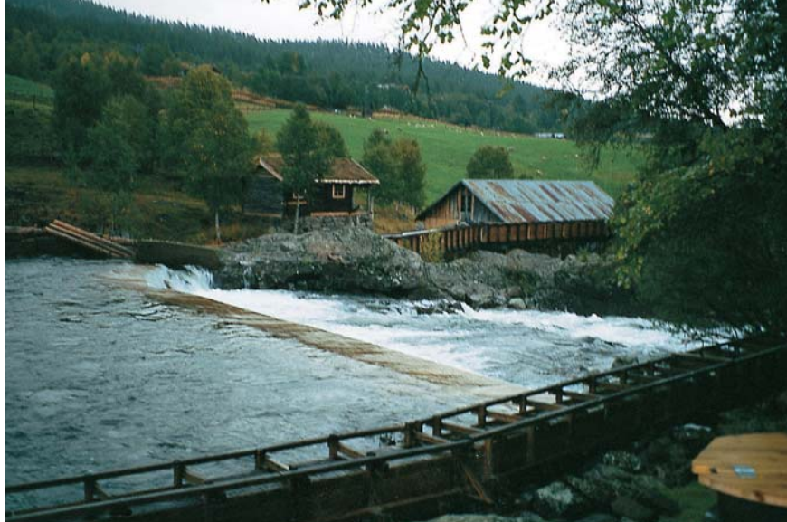
Figur 8.1 Betongterskel ved Atnosen, Hedmark. Foto: NVE.
