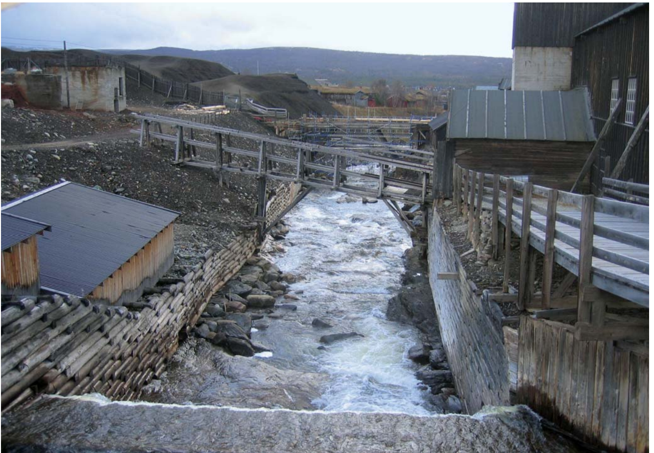
Figur 6.2 Restaurerte tømmerkister og murer sikrer slagghauger og elvebredder mot Hitterelva i Røros. Foto: Einar Sæterbø, NVE.
