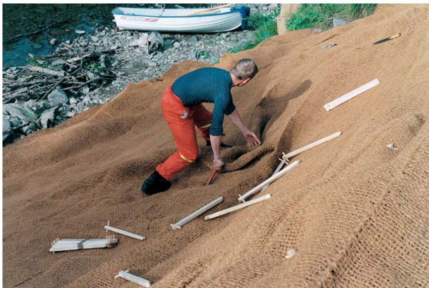
Figur 9.4 Utlegging av kokosmatter i Reisaelva. Foto: NVE.
