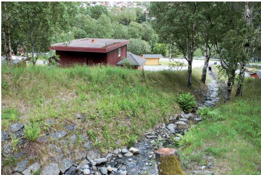
Figur 6.29 Bekken Lysa i Årdal utsatt for flomskred. Sikret med massebasseng og ledevoller. Foto Jomar Berheim, NVE.
