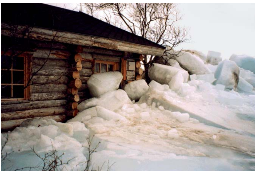
Figur 3.23. Ispåkjenning mot hytte under isgang i Tanaelva. Foto: Randi Pytte Asvall.
