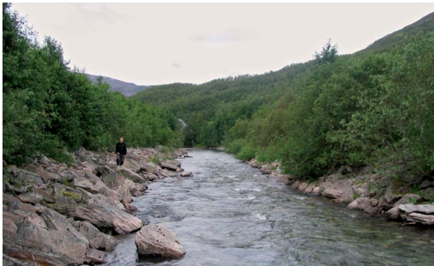
Figur 7.11 Fra Bognelva i Alta hvor erosjonssikringsanlegget langs venstre bredd er fjernet langs denne strekningen. Deler av steinfyllingen er lagt ut i elva for å variere strømningsmønsteret og gi et mer naturlig vassdragsmiljø. Siste bilde er tatt like etter gjennomføringen. Foto: Knut Aune Hoseth og Anders Bjordal.
