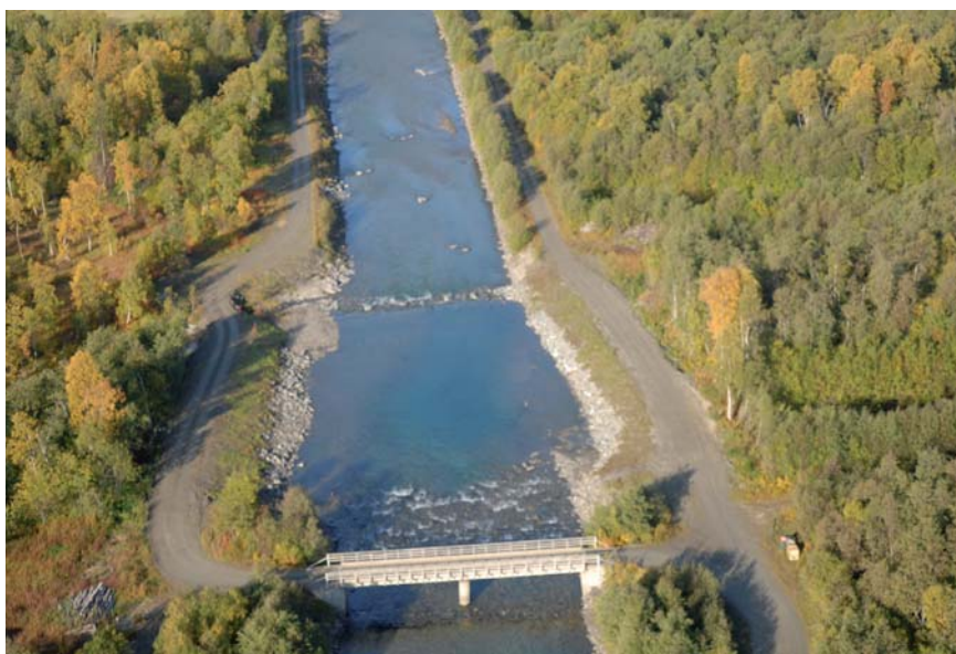
Figur 8.10 Kanalisert elvestrekning med terskel nedenfor brua i Salangselva ved Bones, Bardu. Elveprofilen er utvidet nedenfor terskelen og det er bygd en ny mindre terskel nedenfor kulpen for å hindre bunnsenking. Lenger ned ses utlagte steingrupper. Foto: Knut Aune Hoseth.
