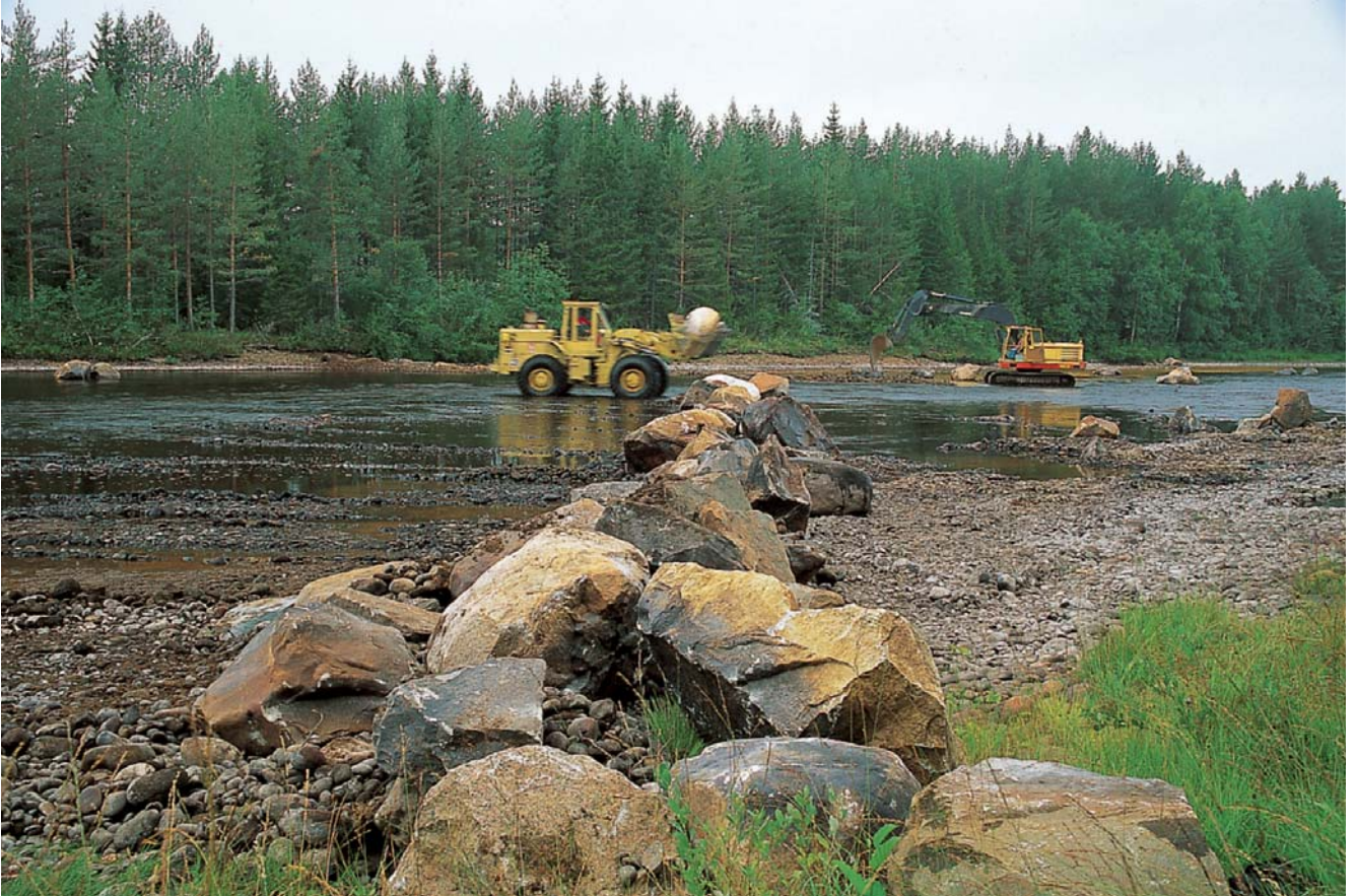
Figur 8.13 Bune under bygging. Foto: Arne Hamarsland.
