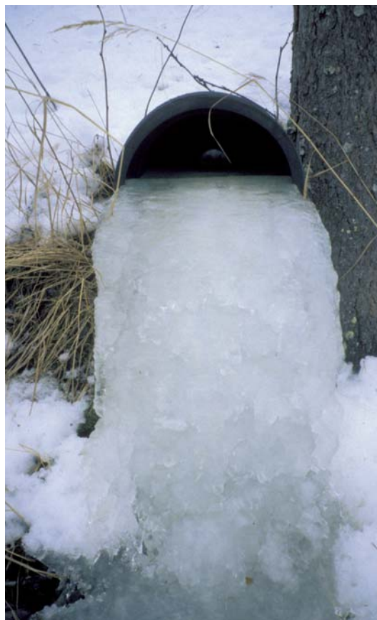
Figur 3.12. Svellis i stikkrenne. Foto: Knut Aune Hoseth.
