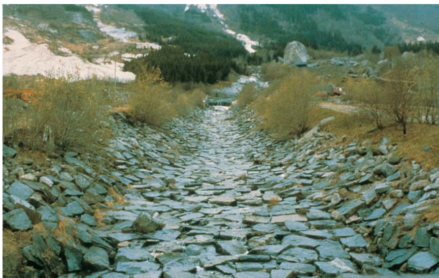
Figur 6.28 Plastring av elvebunn og sider i den bratte Tokheimselva ved Odda er mer preget av godt skjønn, utsorterte steiner av jevn og god størrelse og godt håndlag enn av ingeniørmessige beregninger. Foto NVE.
