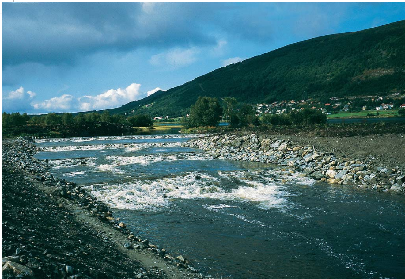
Figur 8.8 Flere terskler i serie i Hareidselev, Hareid, Møre og Romsdal. Tersklene ligger ved utløpet av Grimstadvatnet, for å hindre senking av vatnet som har et rikt fugleliv. Det er bygd 4 terskler av stor stein med tetning av membran. Foto: NVE.
