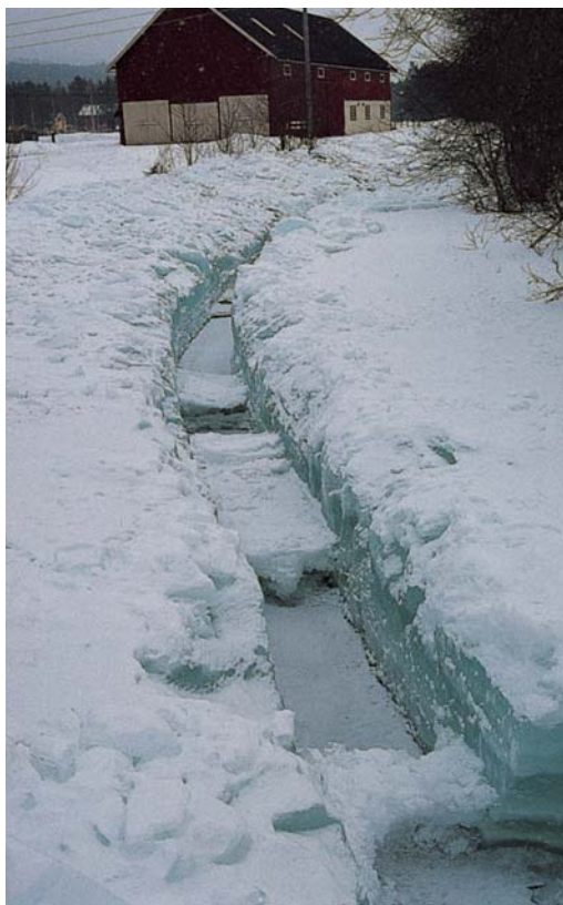
Figur 3.17. Graving av grøft i svellis konsentrerer vannstrømmen og kan gi rask nedskjæring i ismassene. Tysla i Rendalen, Hedmark. Foto: Are Mobæk.
