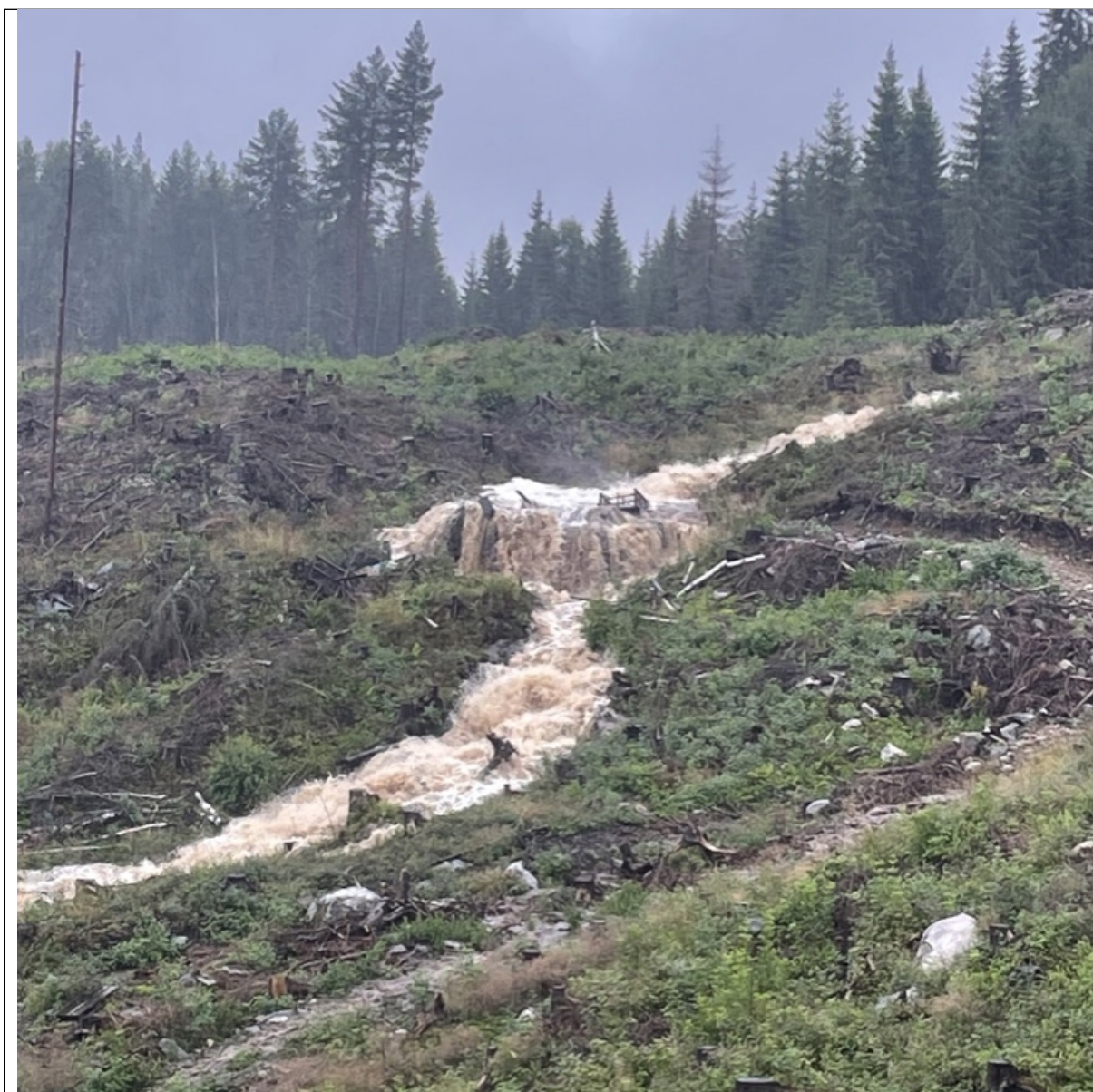
Inntaksdam under uværet Hans 7. august 2023. (vannføring fra Abbortjern, Setermyra, Hæringsstigen og Surelvdalsbekken)
