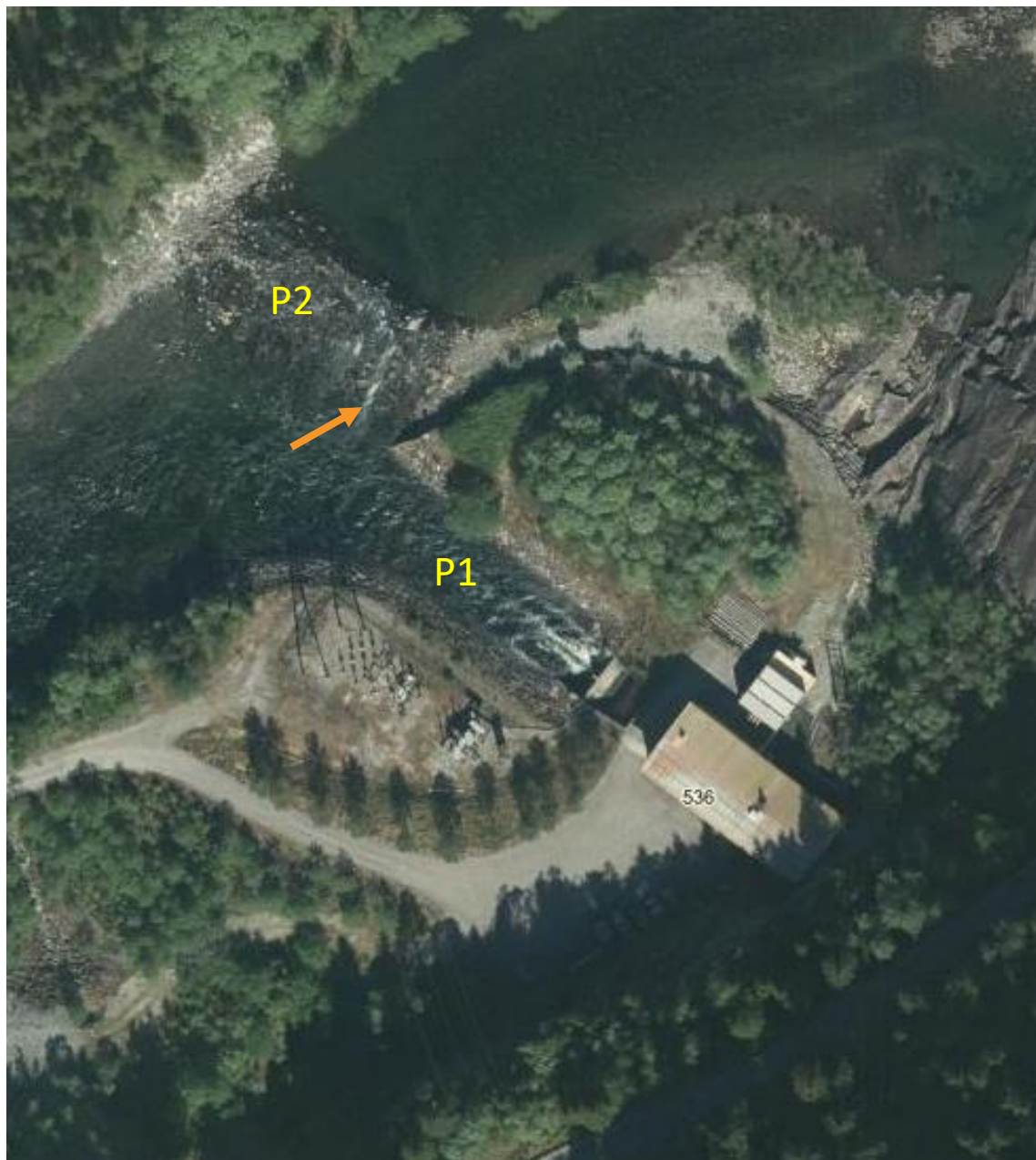
Figur 4. Oversikt over samtløpet avløpstunnel fra Hellandsfoss kraftverk og steinterskel (P1 og P2). Oransje pil angir lokalisering av strømkonsentrator gjennom terskelen (Figur 5) (norgebilder.no).
