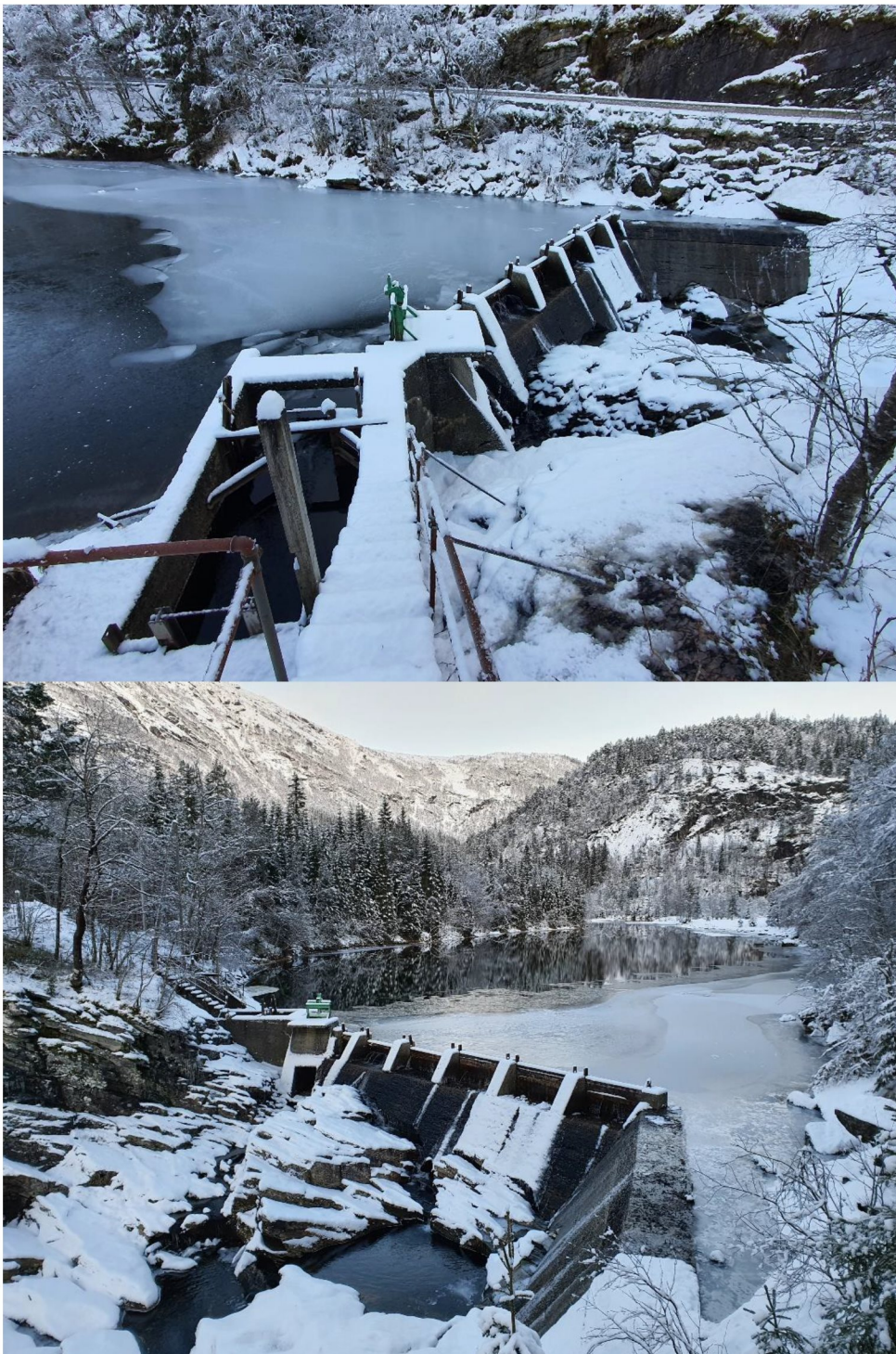
Figur 2. Damanlegget som skaper inntaksmagasinet til Hellandfossen kraftverk. Det øverste bildet er tatt fra nordsiden, mens det nederste er tatt fra sørsiden (foto: M. Kraabøl).
