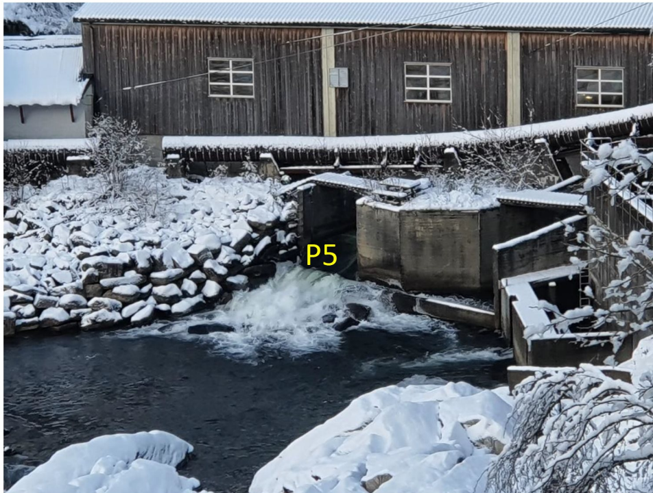
Figur 7. Utløp fra kraftverk er midt i bildet, mens utløp fra fisketrappa ses til høyre i bildet (bildet er tatt fra østsiden). Begge vannveiene munner ut i felles resipientkulp (foto. M. Kraabøl).
